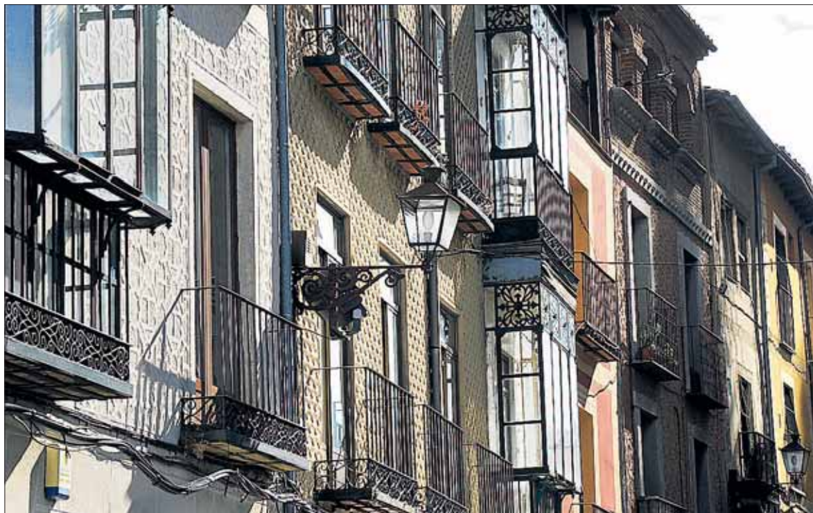
Propietarios de edificios del recinto amurallado y otras zonas históricas tendrán que pagar IBI el año próximo. / KAMARERO
