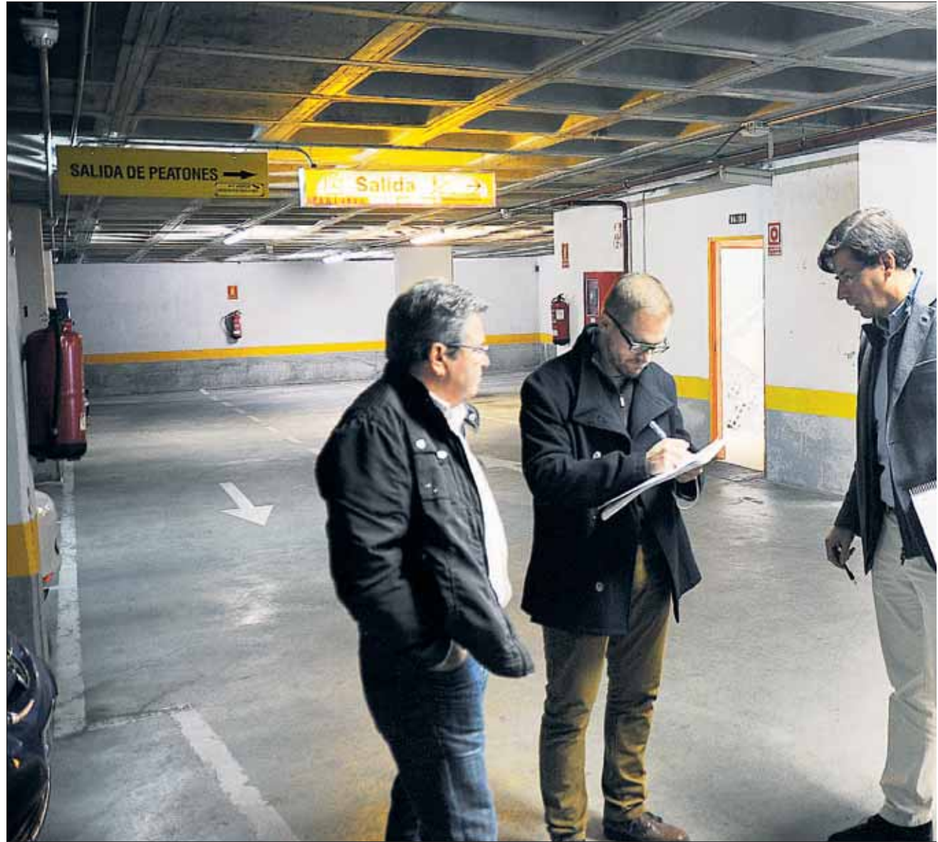
Agentes de la Policía Local, acompañados por técnicos municipales y un notario realizaron ayer una inspección a las instalaciones del aparcamiento subterráneo de José Zorrilla.
