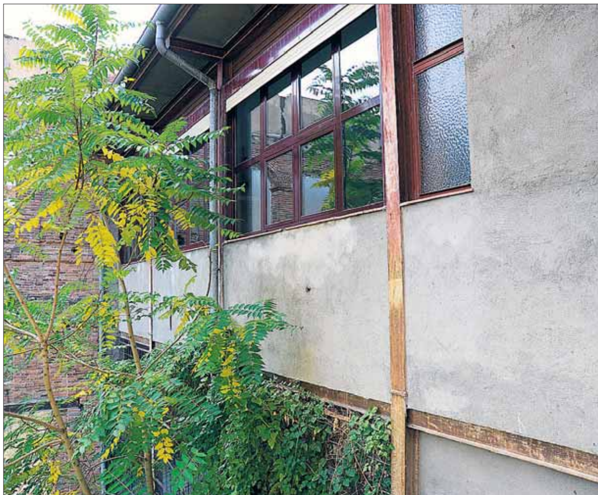
Fachada trasera de la Casa de los Picos, que prevé reformar la Dirección Provincial de Educación. / KAMARERO
