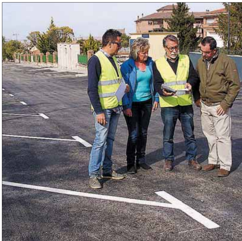
La concejala Paloma Maroto inspecciona las obras con varios técnicos. / E.A.
