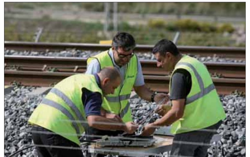
Técnicos de Adif repararon los cables de cobre y de fibra óptica. / EFE
