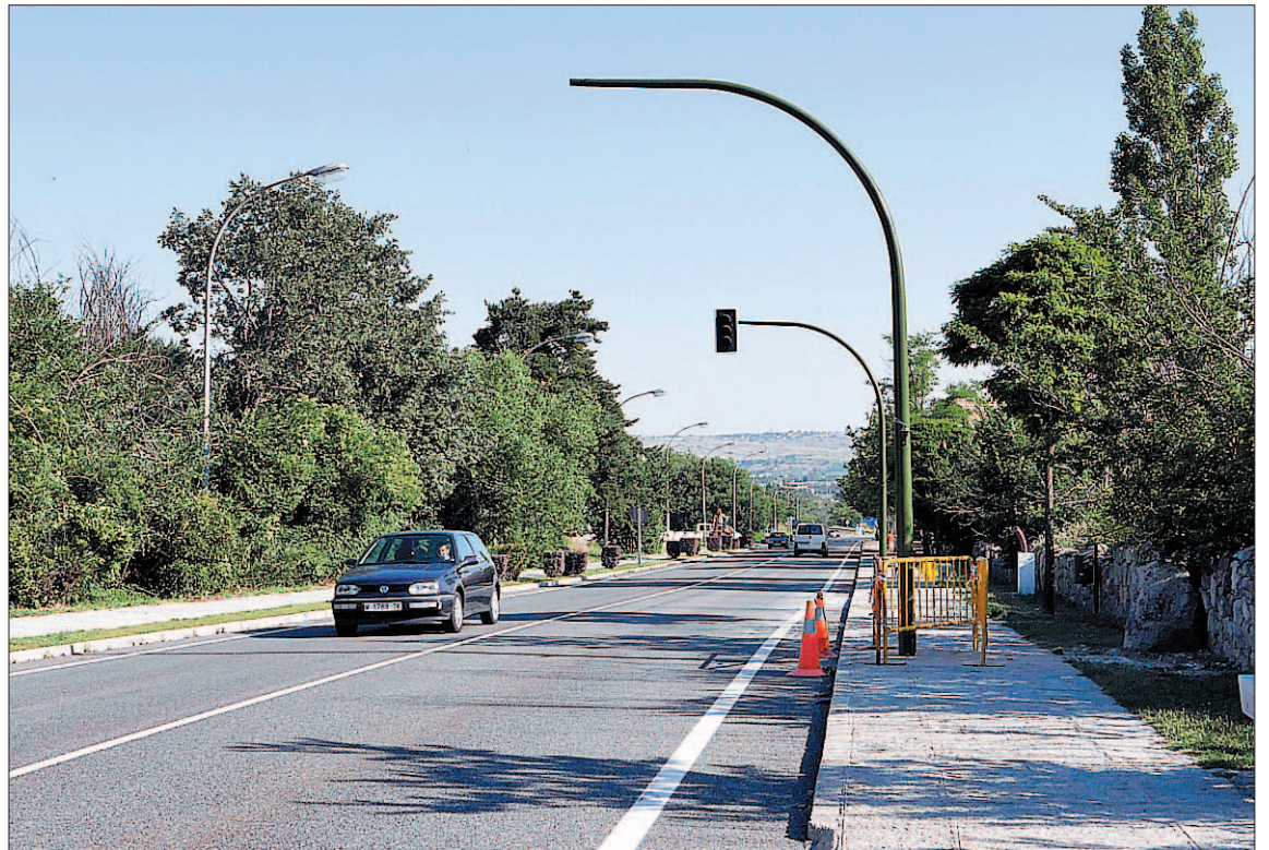
Los nuevos semáforos fueron instalados a comienzos del pasado mes de julio. / PEDRO MERINO
