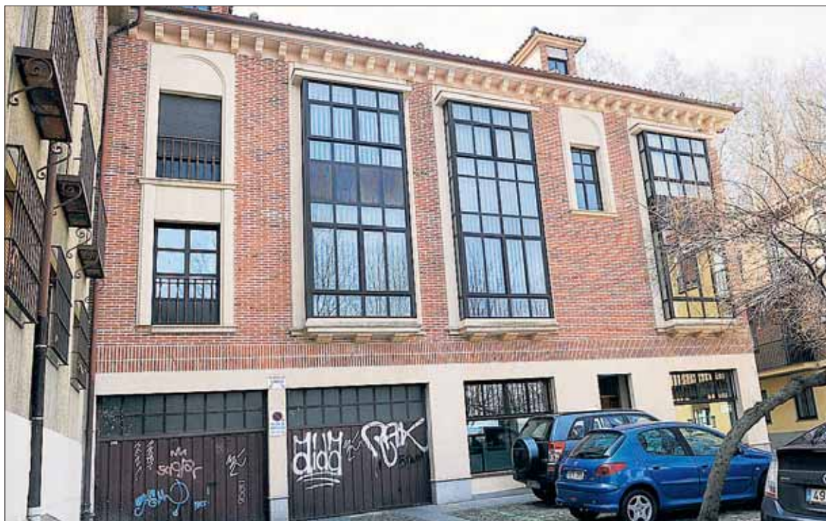
Casa de la calle de la Parra, en el centro de Segovia, cuyo volumen podría consolidarse en un plan especial. / KAMARERO
