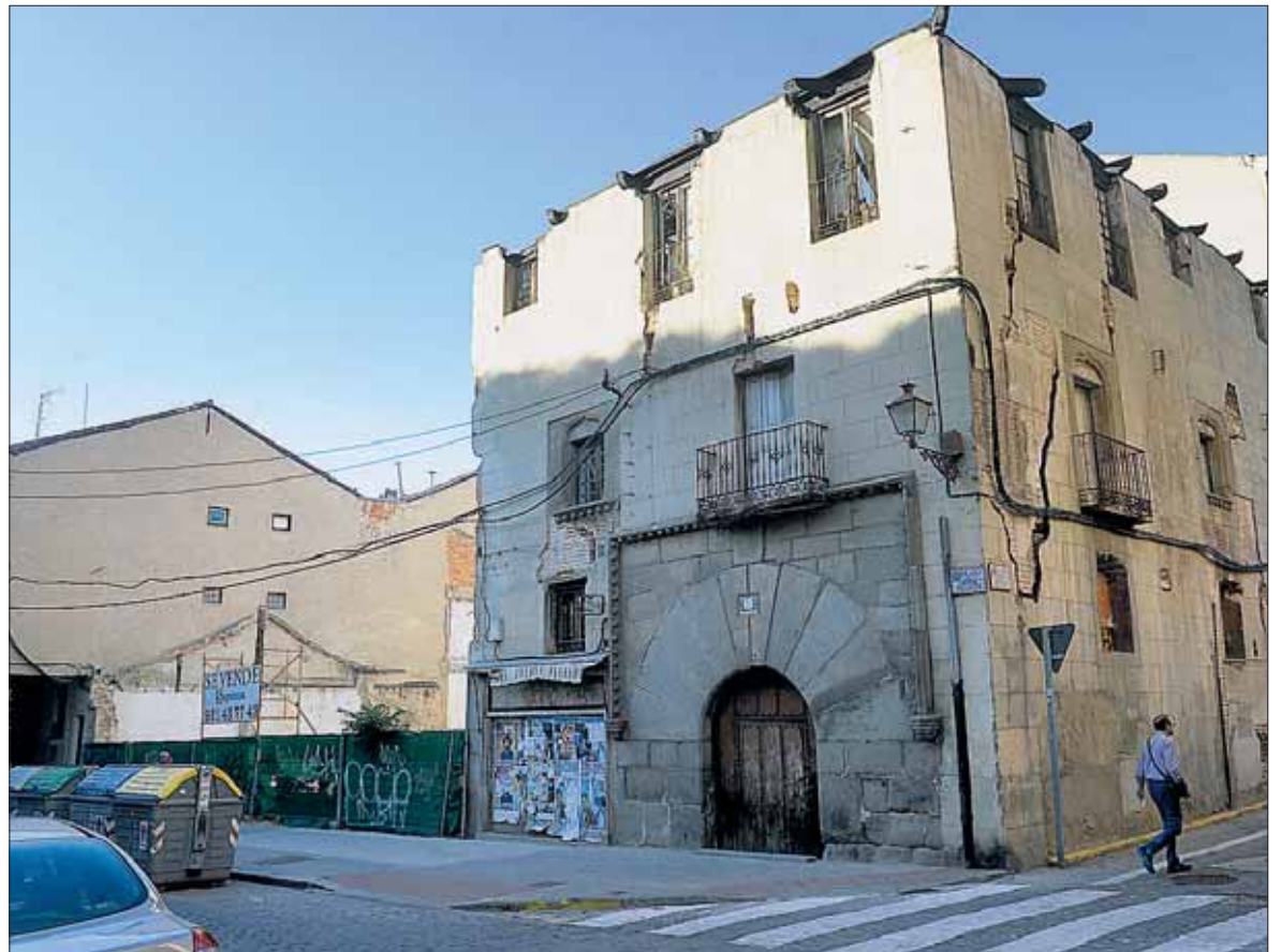
La Casa de los Buitrago se encuentra frente a la iglesia de Santa Eulalia y es un edificio noble del siglo XV. / KAMARERO
