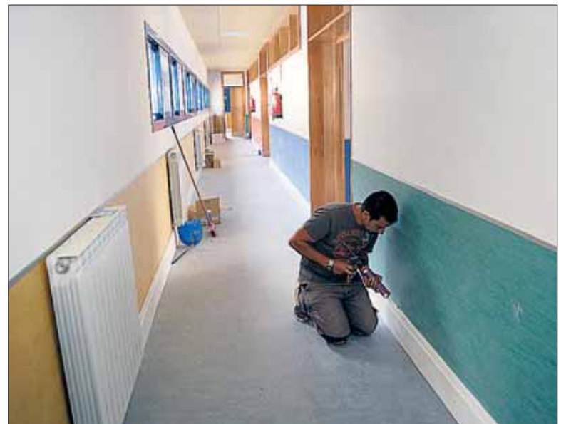
Uno de los técnicos trabajando en el colegio 'Atalaya' de Palazuelos. / KAMARERO
