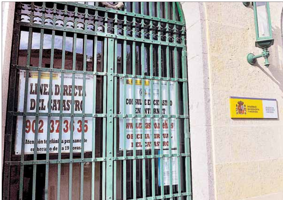
La sede del Catastro se encuentra en la Delegación de Hacienda, antiguo edificio del Banco de España. / KAMARERO
