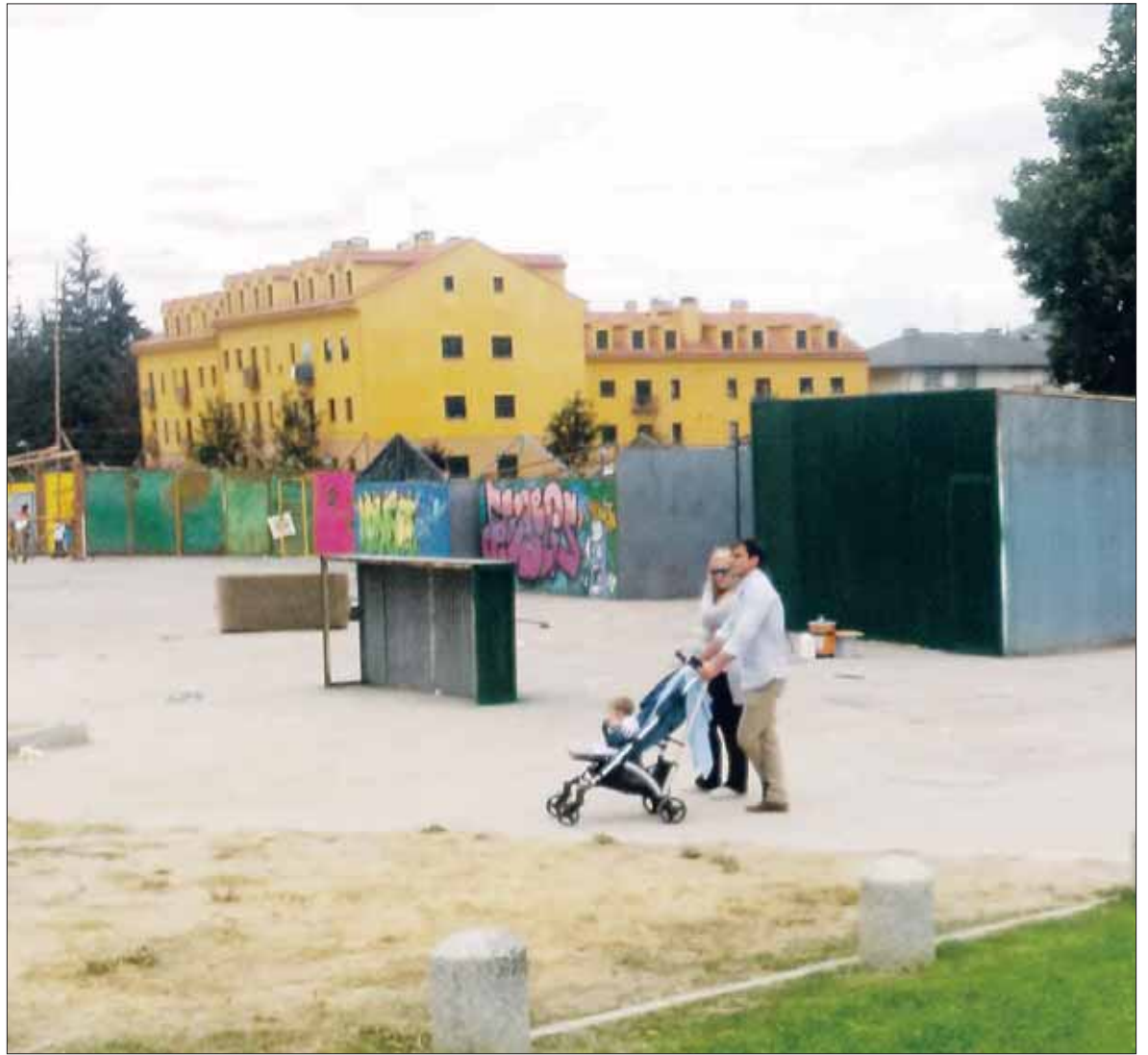
Ya han comenzado los trabajos para ubicar las peñas de las fiestas de San Luis 2015. / JAVIER SEGOVIA
