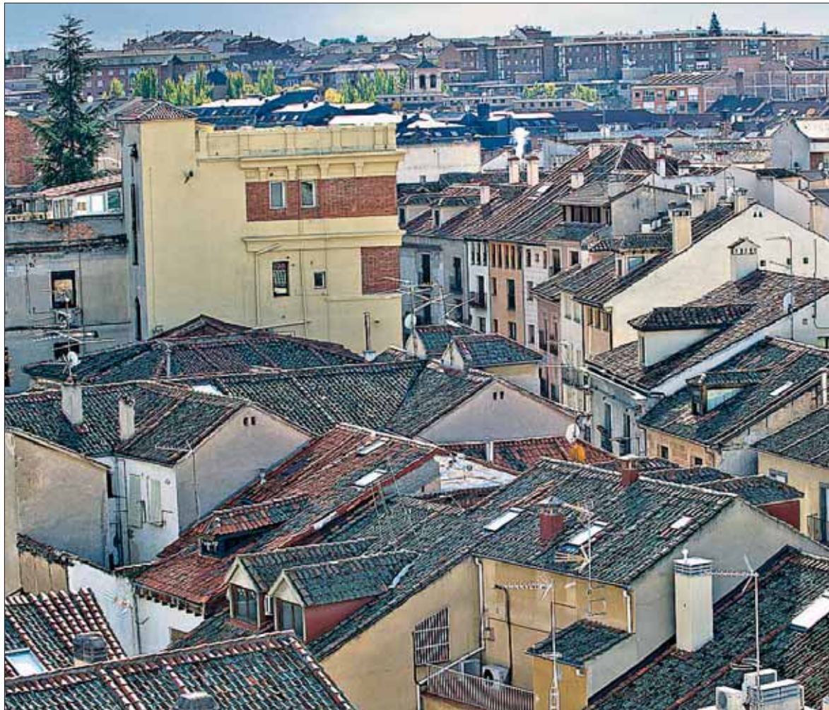
Segovia capital fue una de las primeras ciudades de la región en realizar la Inspección Técnica de Edificios. / KAMARERO
