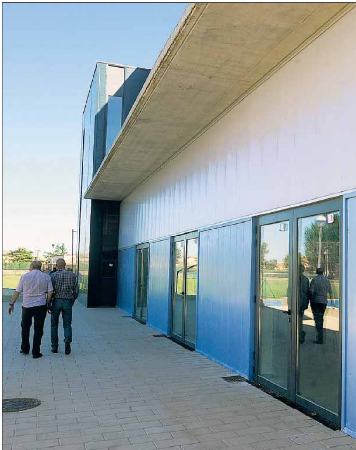
Vista lateral del nuevo pabellón de Nava, para cuya finalización hacen falta un millón de euros, según el alcalde. / KAMARERO
