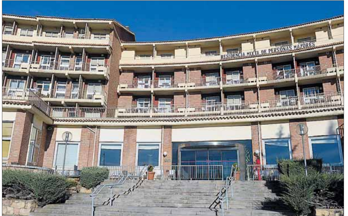
El sindicato denuncia falta de personal y unas obras que incumplen la normativa en la Residencia Mixta. / KAMARERO
