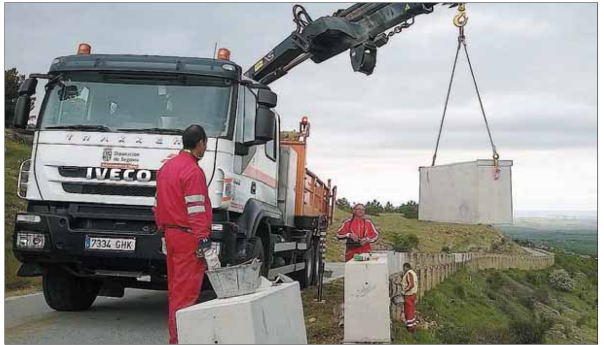
Imagen de la colocación de los malecones por parte de los operarios de la Diputación. / EL ADELANTADO
