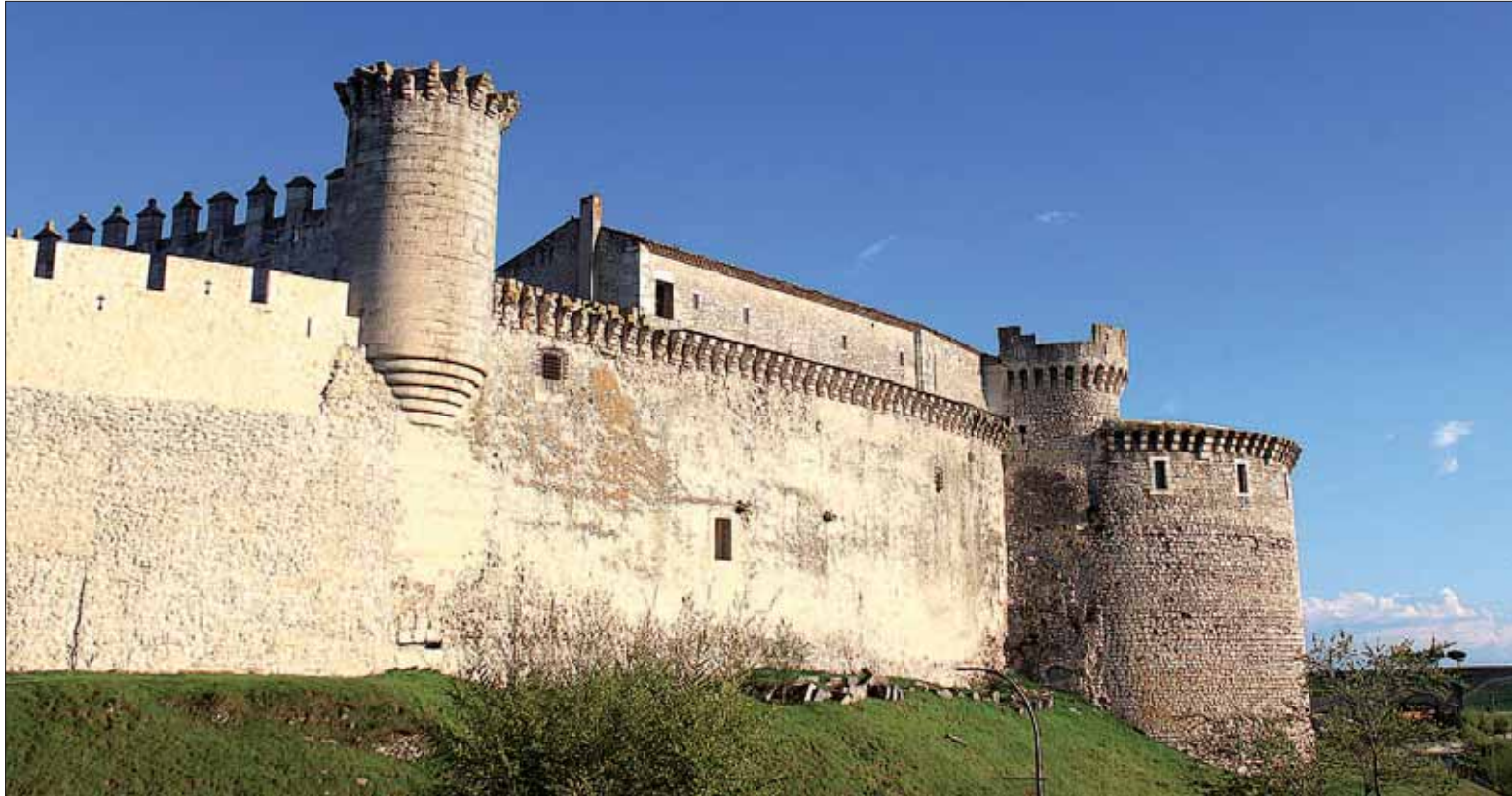
A la altura del piso de la segunda planta del Torreón grande, en su confluencia con el torreón pequeño, se practicó el boquete. / JUAN CARLOS LLORENTE
