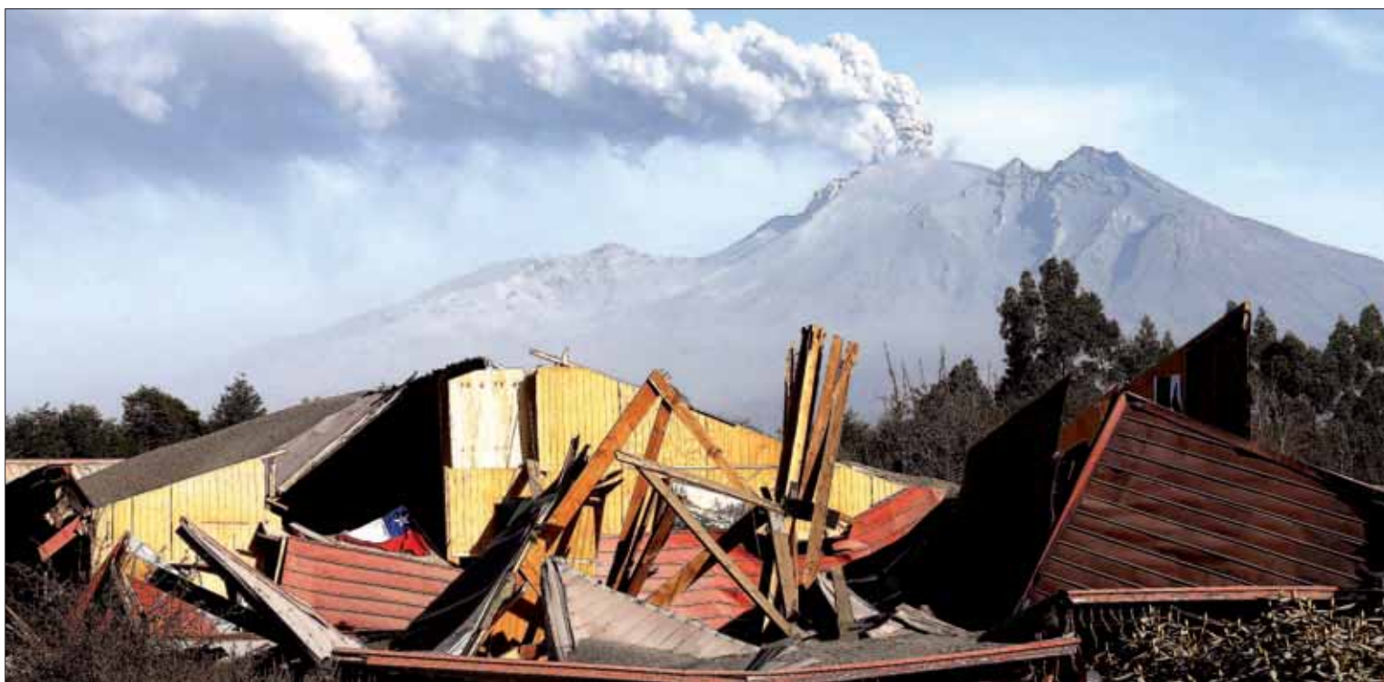
Imagen de un restaurante chileno que se derrumbó por el peso de las cenizas tras la erupción del volcán 'Cabulco' en la localidad de Ensenada. / EFE
