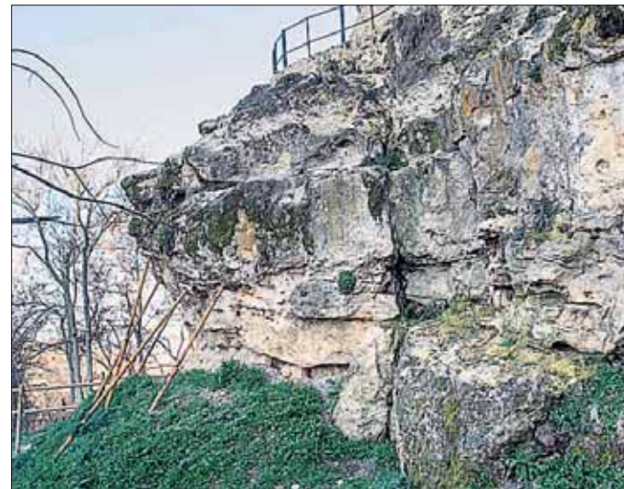
Se tratará de consolidar la roca para evitar derrumbamientos. / KAMARERO
