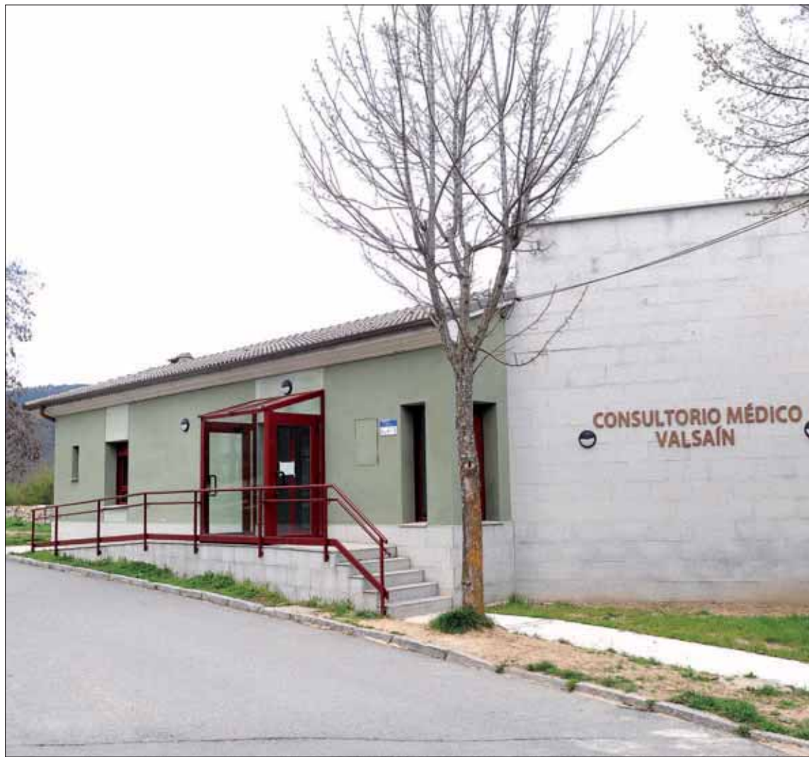
Edificio del nuevo consultorio médico de Valsaín. / JAVIER SEGOVIA
