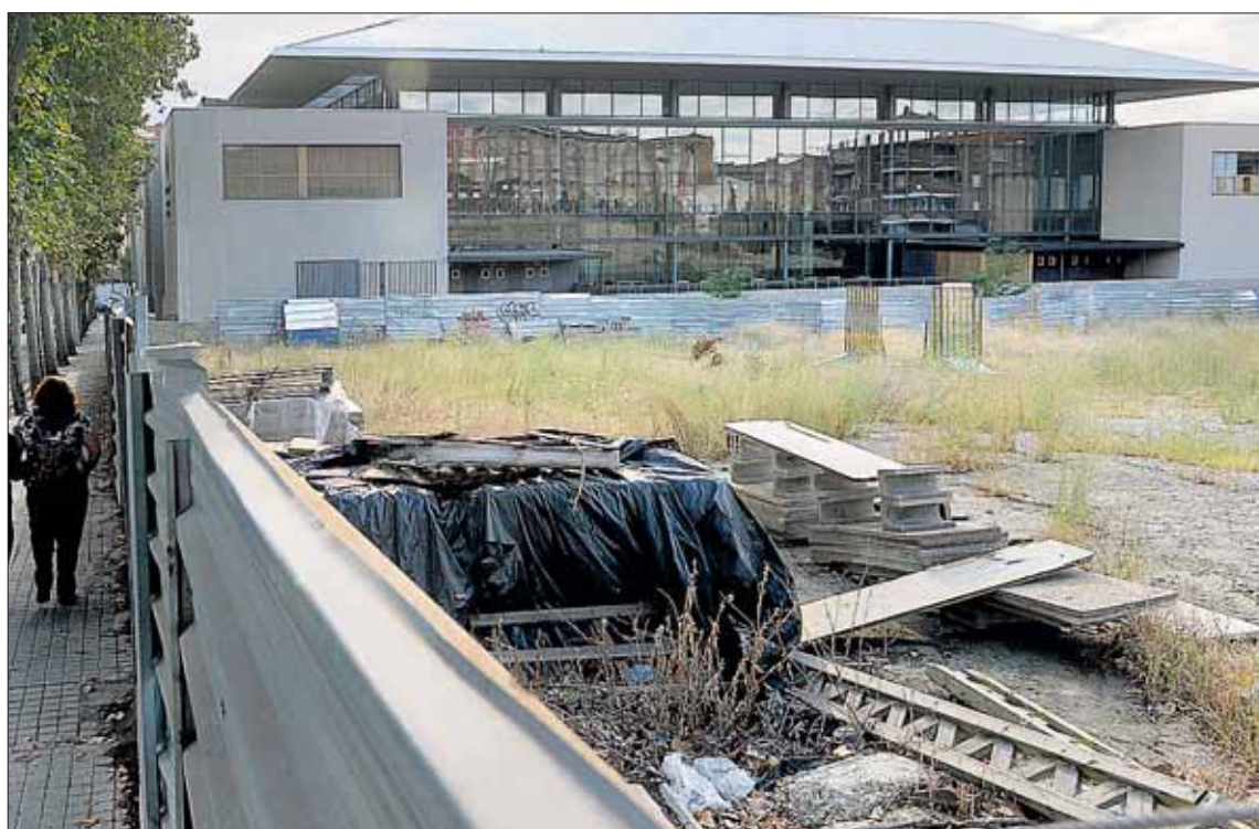
La parcela donde se levantará la segunda fase del campus está llena de maleza y escombros del antiguo Regimiento. / KAMARERO
