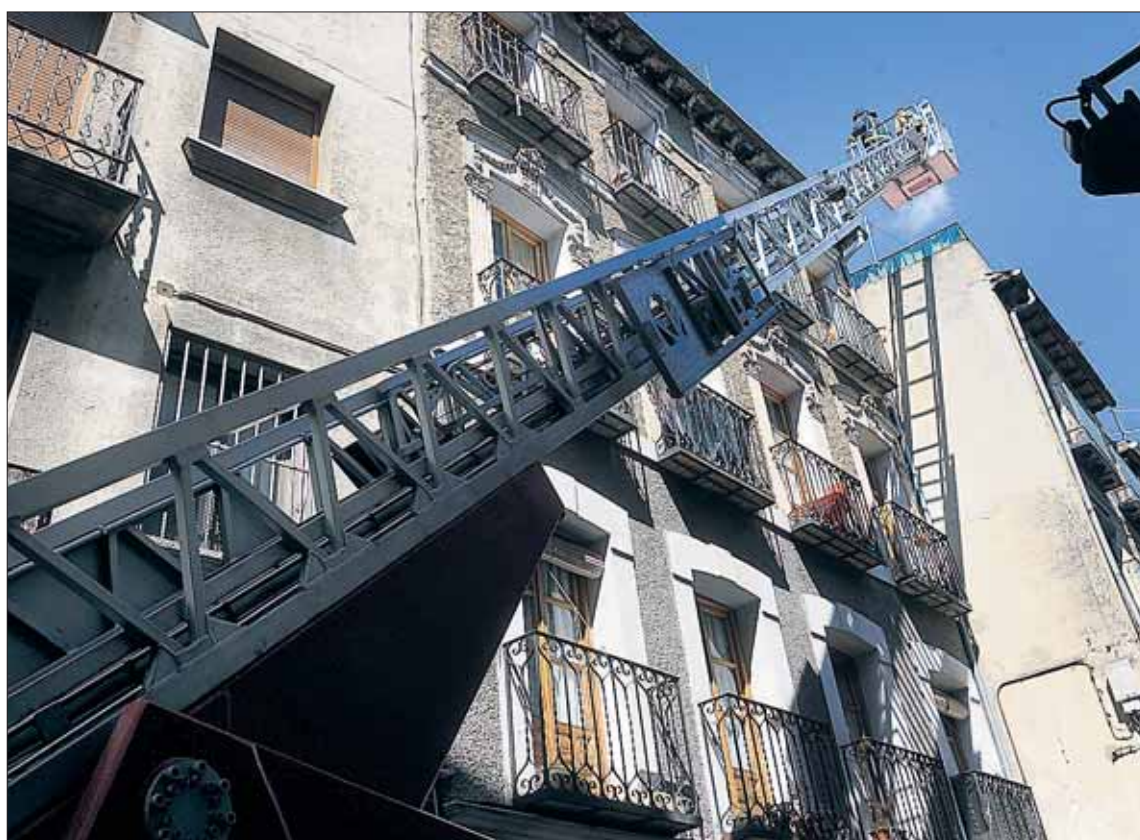
Las dificultades de acceso a algunas zonas de la muralla obligaron a solicitar la colaboración de los bomberos. / KAMARERO
