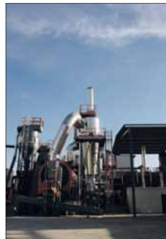
Instalaciones de Naturpellet.
