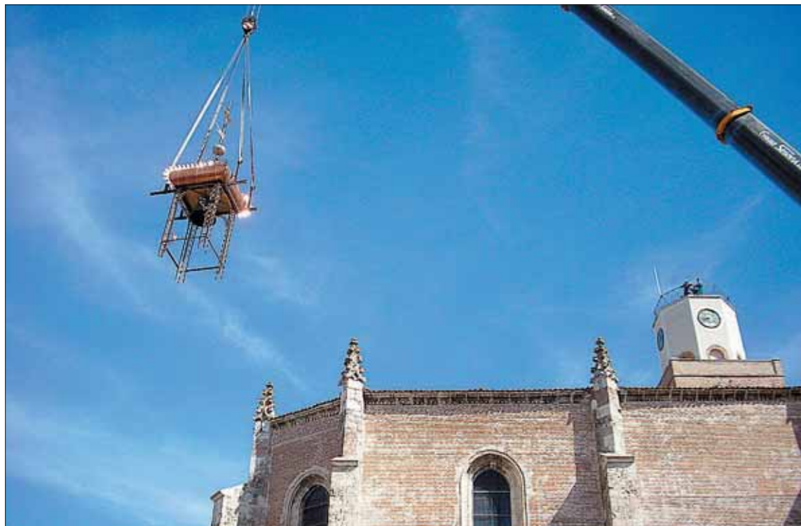
Instalación con grúa de la cúpula de la torre de la iglesia de Coca, una de las más altas de la provincia. / EL ADELANTADO
