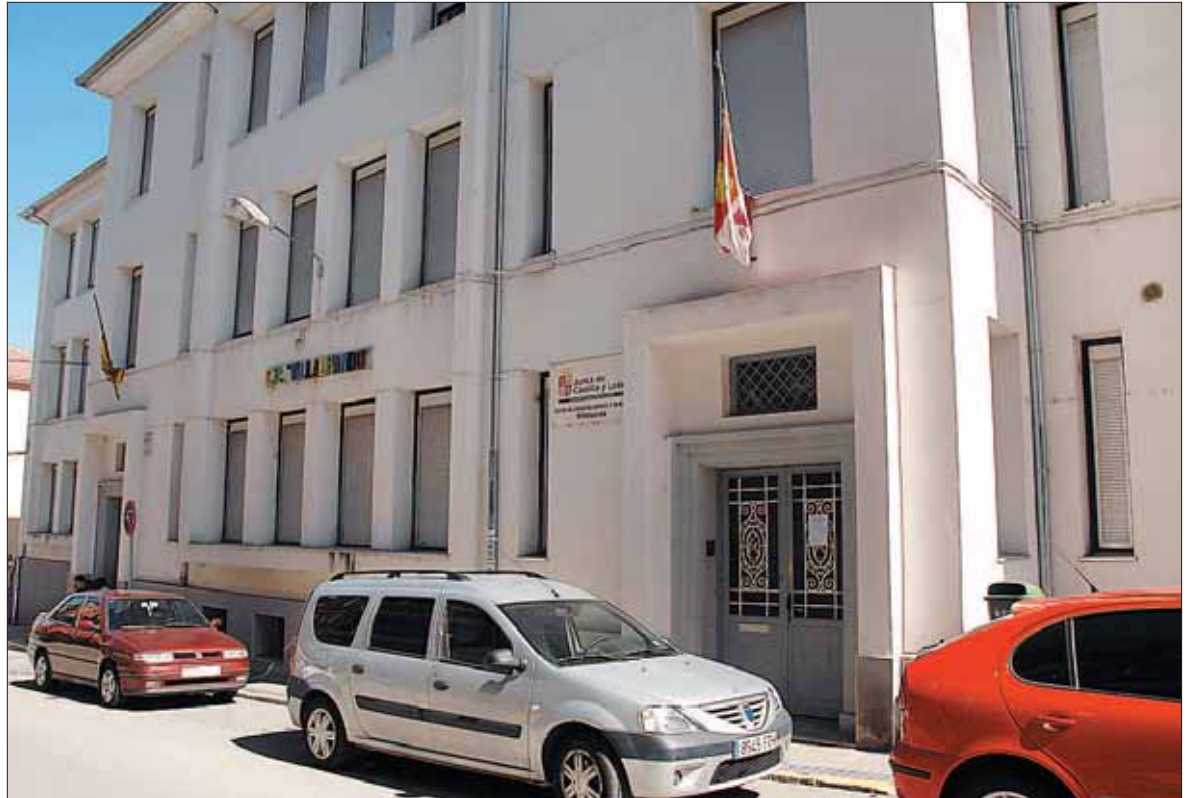
Fachada principal del colegio 'Villalpando', donde una gotera ha generado problemas, según el PP. / EL ADELANTADO
