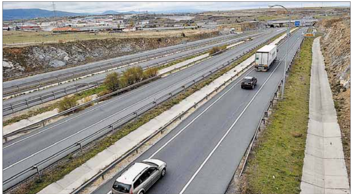
El desdoblamiento de la SG-20 cuenta con un presupuesto superior a los 55 millones de euros. / KAMARERO
