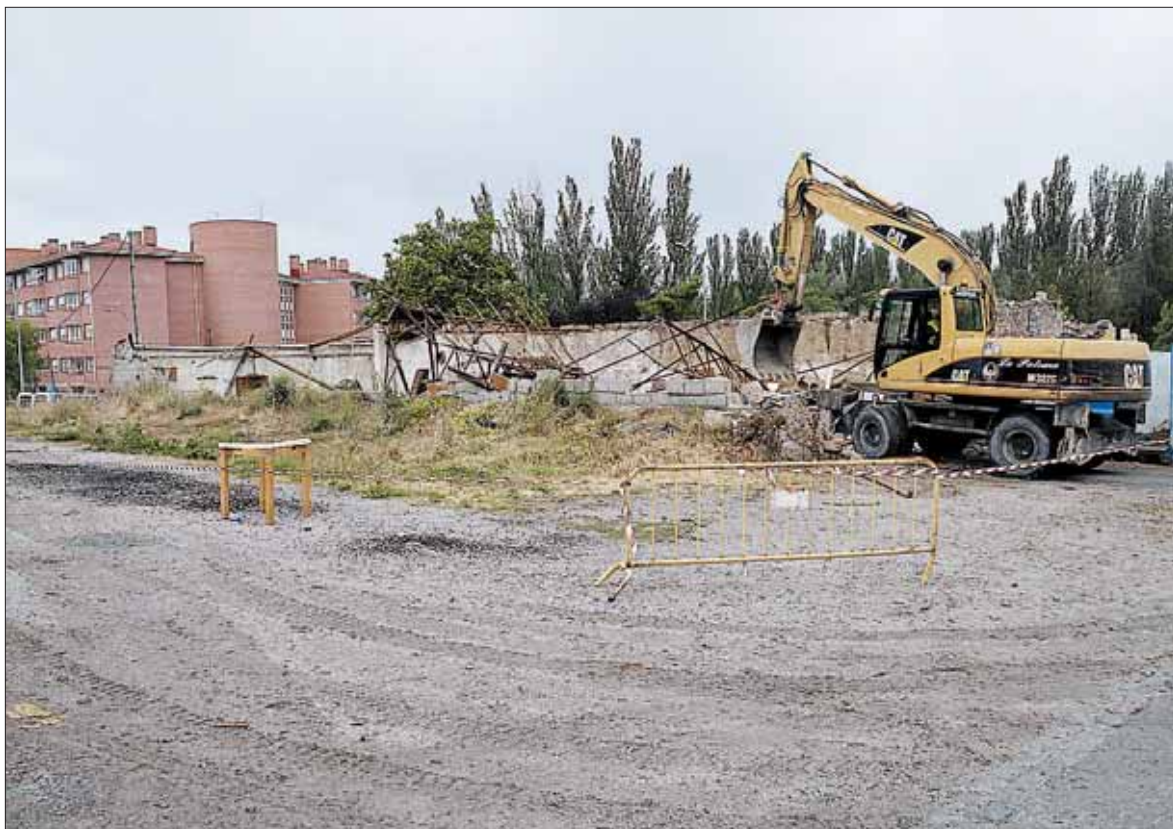
El derribo de la antigua serrería del barrio de La Albuera se ejecutó a finales de mayo de 2014. / JUAN MARTÍN
