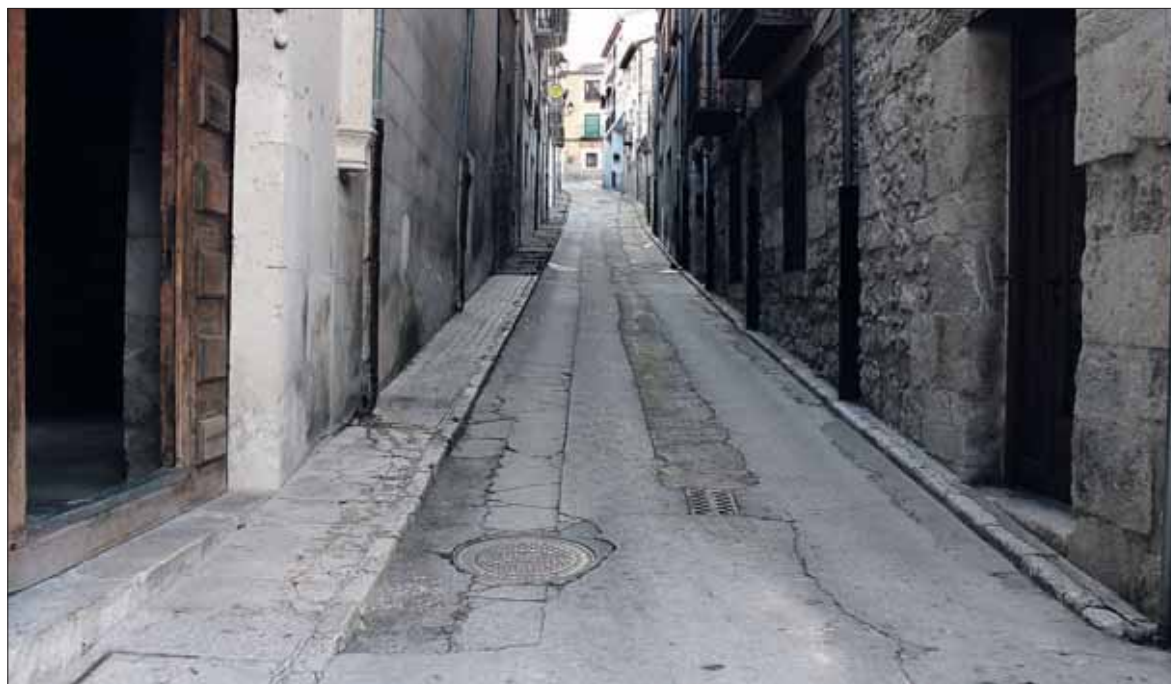
La calle La Morería se adoquinará y se reconstruirán los escalones de la parte izquierda./ CHANTAL NÚÑEZ
