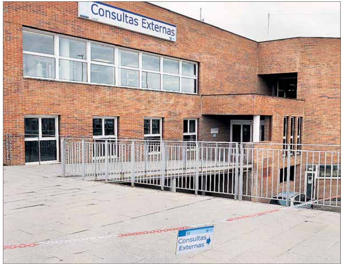
El edificio de Consultas Externas estaba cerrado el pasado jueves para evitar corrientes de aire en el interior. / KAMARERO
