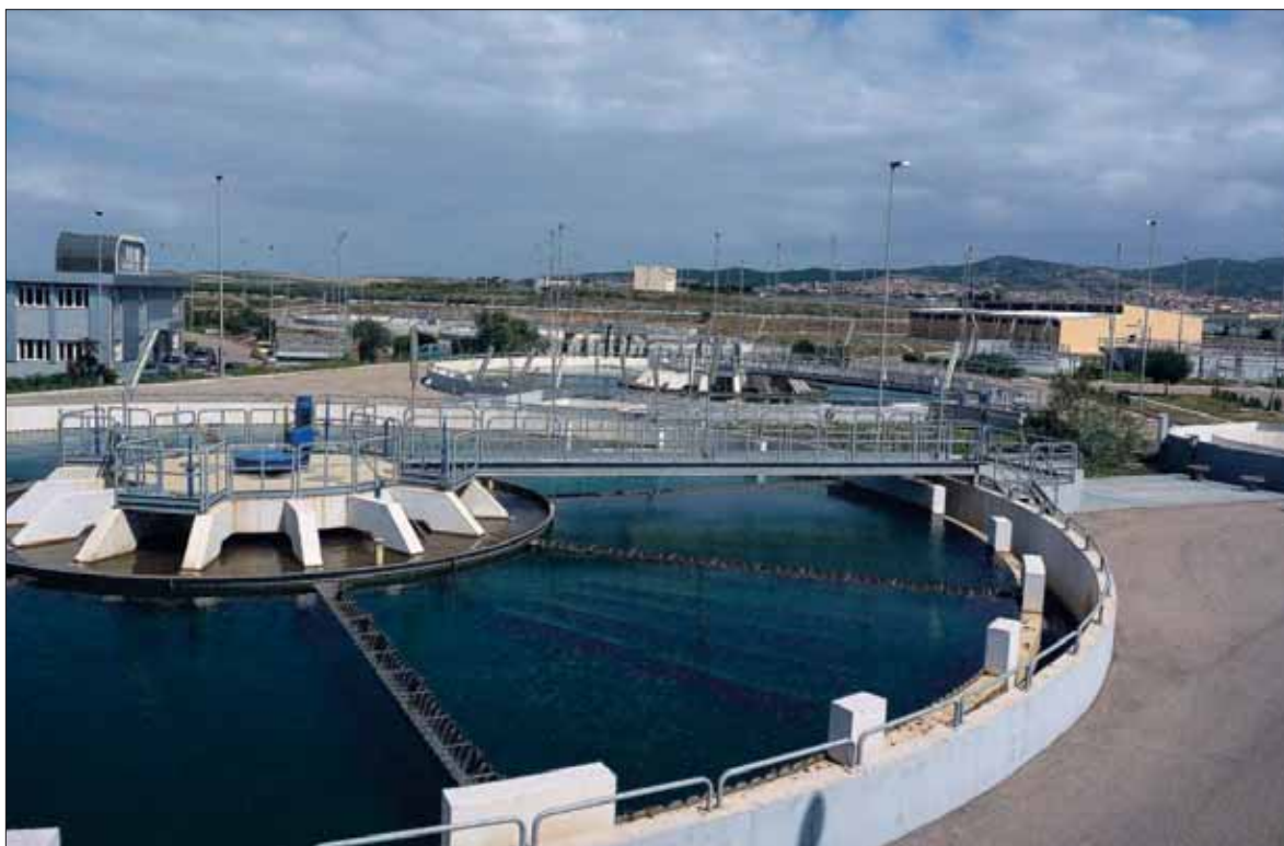
Una de las depuradoras de Castilla y León que están en funcionamiento en la actualidad. / EUROPA PRESS
