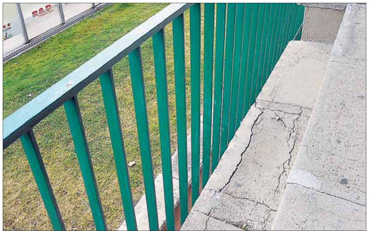
Grietas en las placas de hormigón de la tribuna del campo de La Albuera. / KAMARERO
