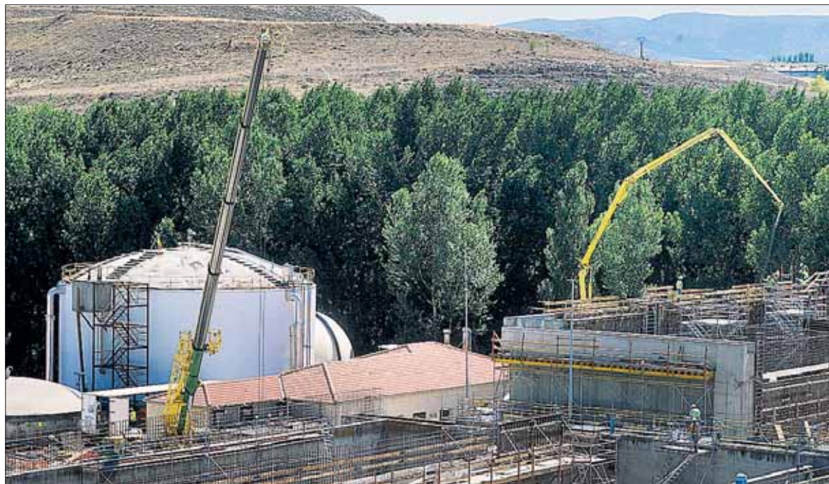
Las grandes grúas continúan presentes en la zona del valle de Tejadilla, donde se encuentra la EDAR. / KAMARERO
