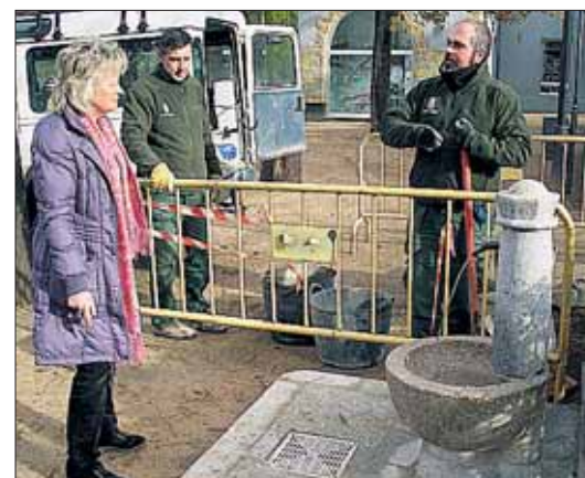
Aspecto de la nueva fuente ya instalada.
