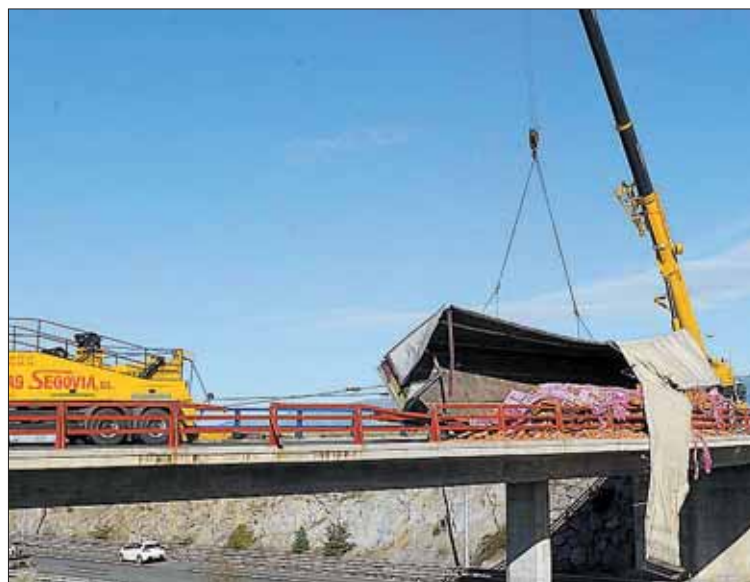
Accidente de un camión de ladrillos, en las cercanías de Hontoria. / KAMARERO
