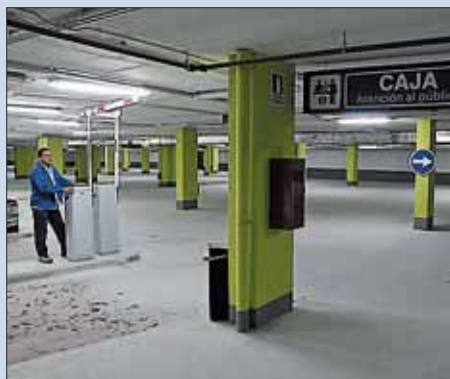
Interior del aparcamiento.
