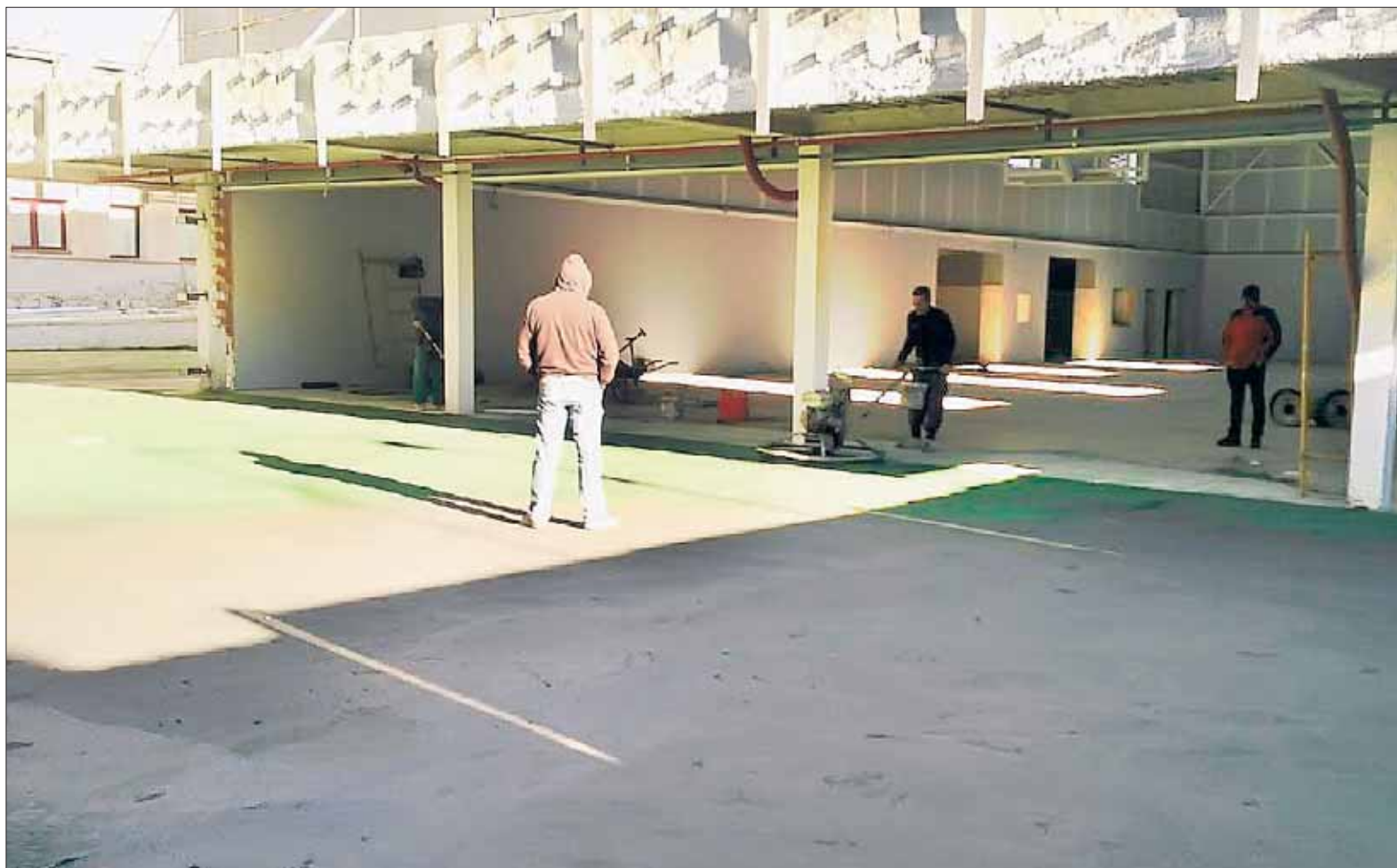
Una de las zonas de actuación de las últimas horas ha sido el patio situado entre el pabellón y el edificio de aulas, donde se ha creado una pista de hormigón verde. / E. A.
