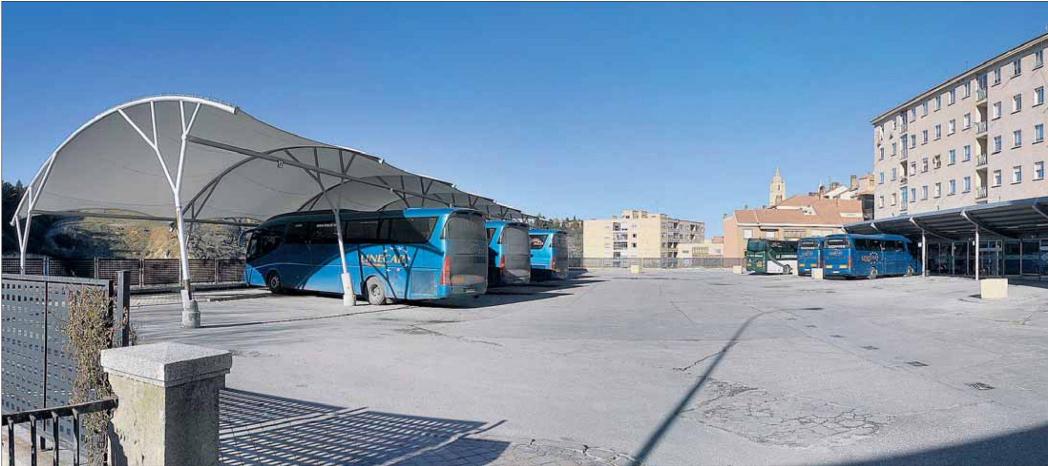
Una de las principales intervenciones de la reforma es la cubrición de la campa con una carpa ligera, estructurada en tres módulos. También se renovará el pavimento, que hoy presenta un lamentable estado de deterioro. / KAI
