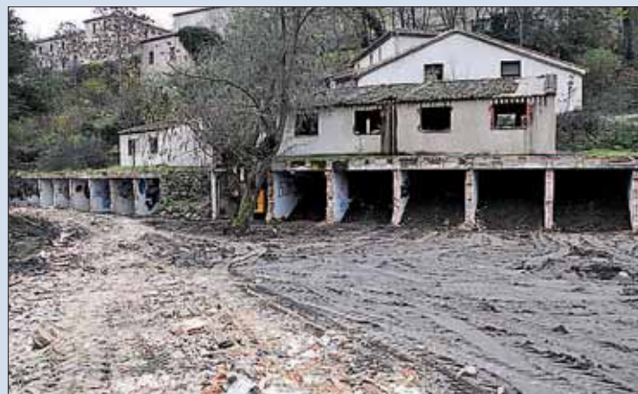
Así van las obras de demolición de los miniapartamentos ilegales. / J. M.
