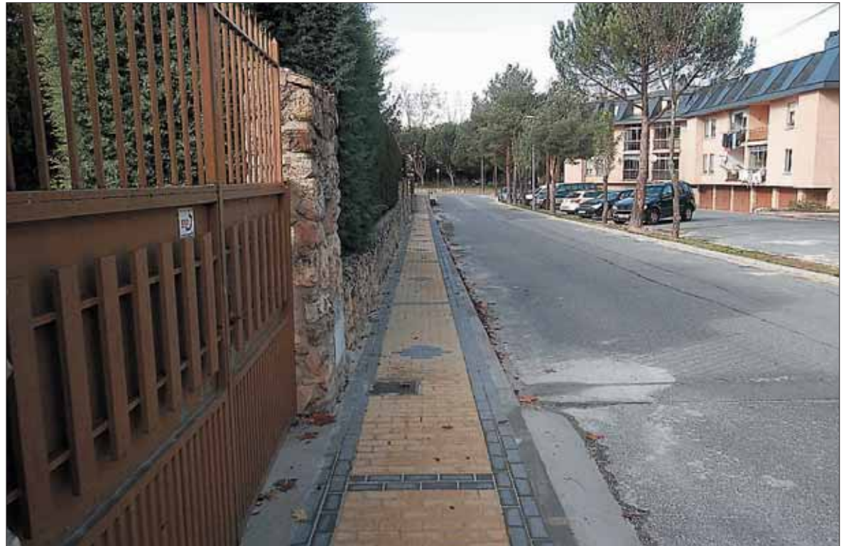
El Ayuntamiento acometerá el asfaltado de varias calles en mal estado. / EL ADELANTADO
