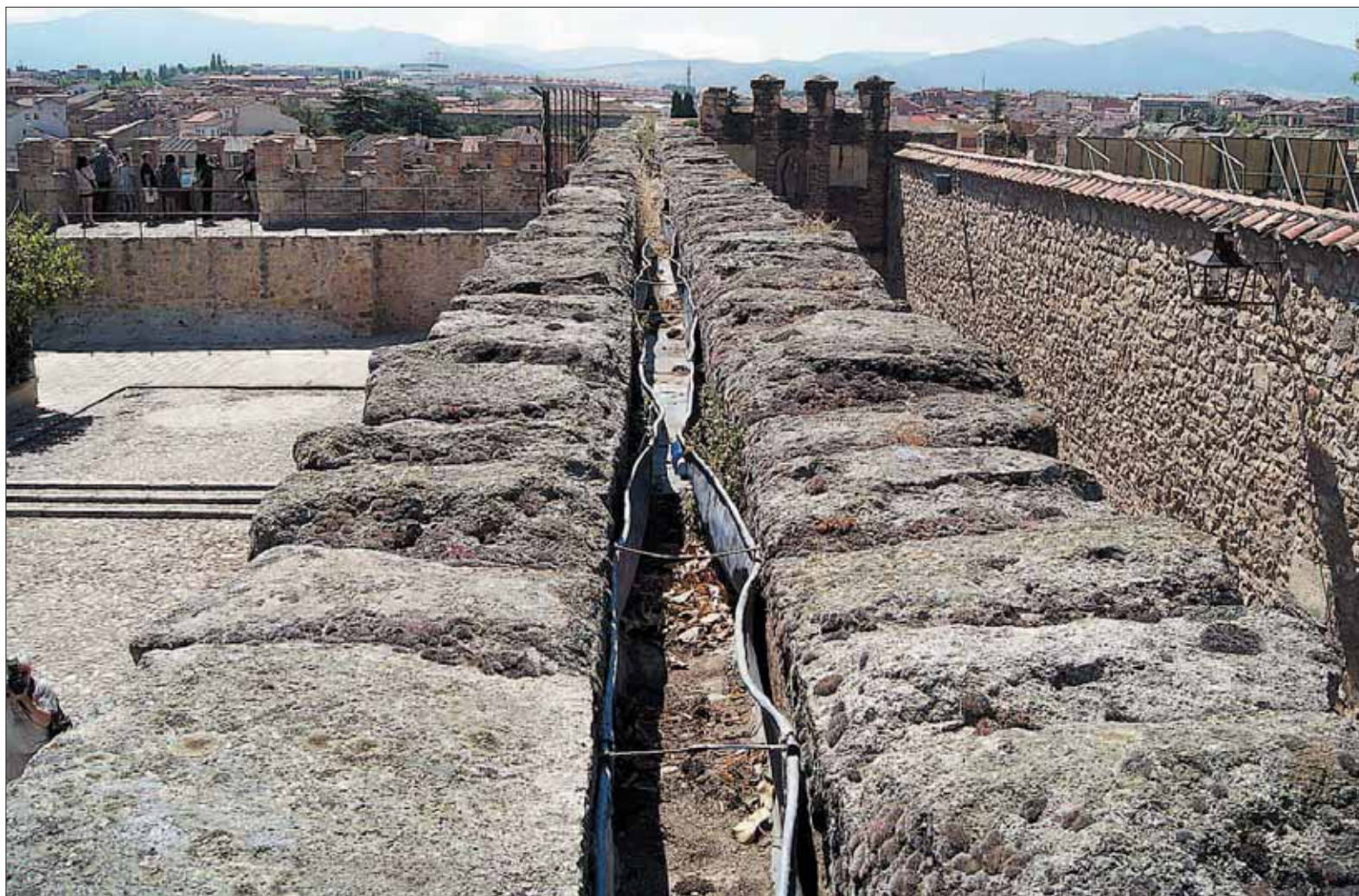
Detalle del canal del Acueducto, sobre el que hace quince años se colocó uno de plomo (visible en la imagen), ahora eliminado. / JUAN MARTÍN
