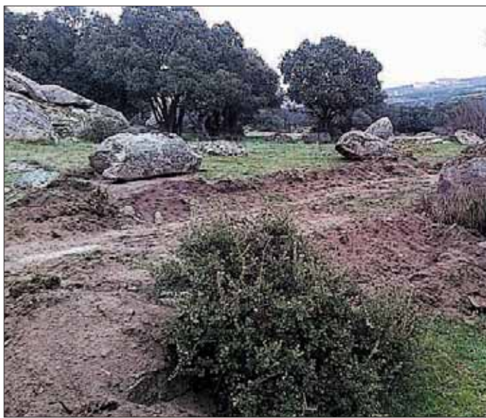
Obras de construcción del 'camino natural', en la Cañada Real. / E.A.
