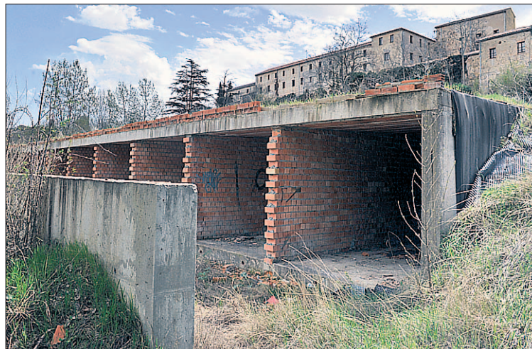
Los minipisos se camuflaron en el interior de un muro de contención. /KAMARERO
