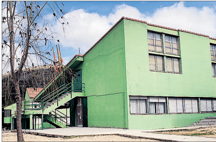
Fachada exterior del colegio de San Rafael. / EL ADELANTADO
