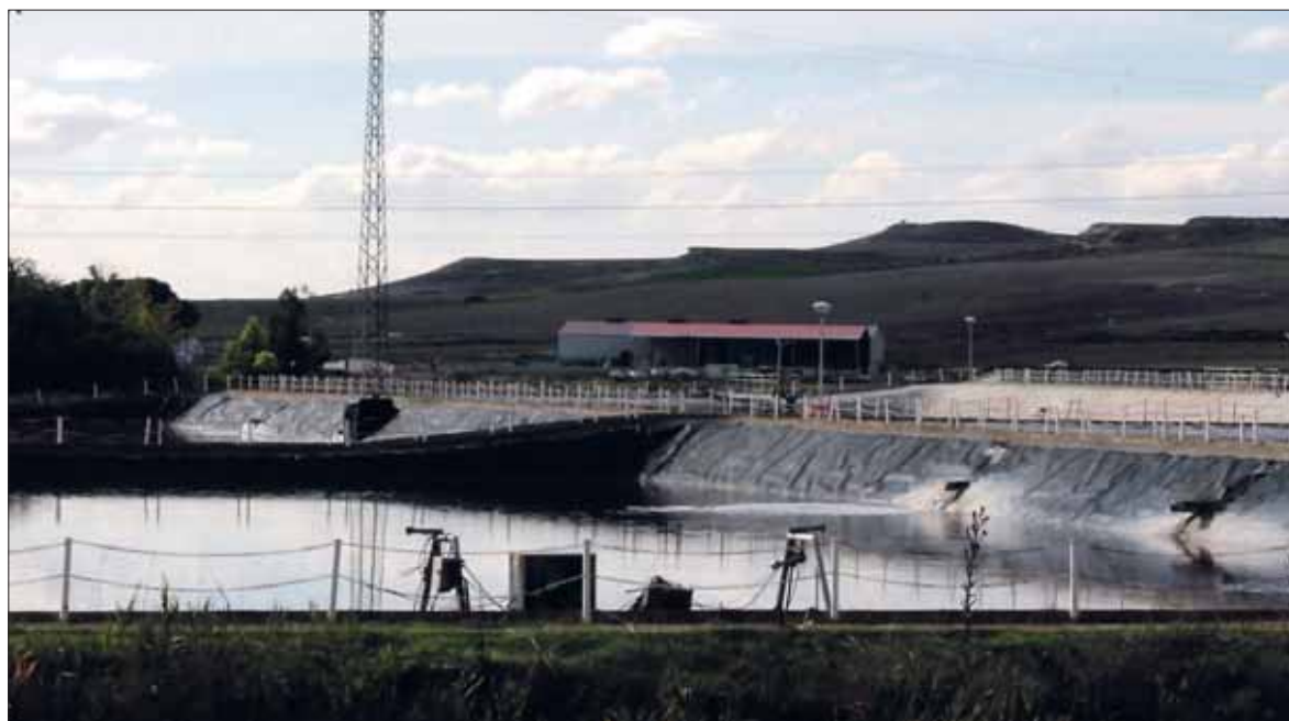
Las actuales balsas no cumplen con los parámetros de vertido. / CHANTAL NÚÑEZ
