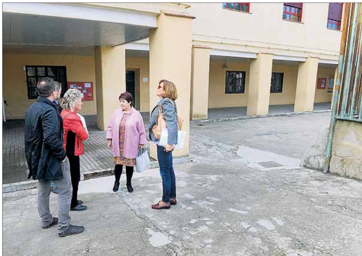
La alcaldesa Clara Luquero comprobó el mal estado del pavimento de la zona de recreo del colegio 'El Peñascal'. / KAMARERO
