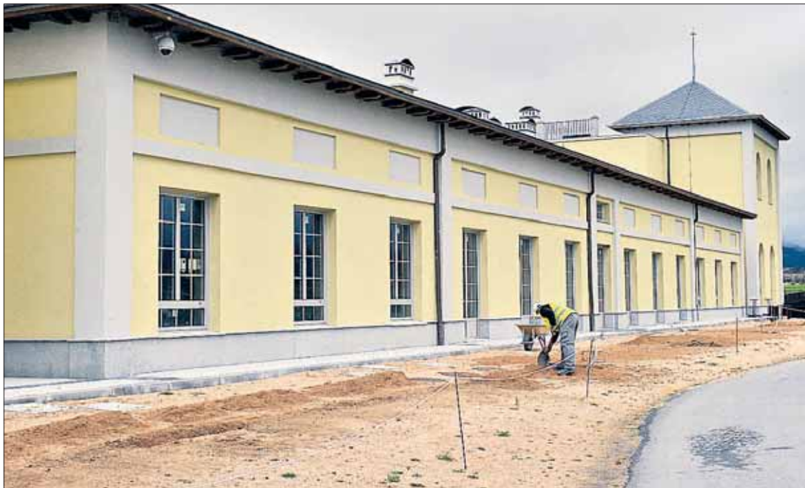
Las obras del Palacio de Congresos, adjudicadas por 3,8 millones, arrancaron el pasado mes de julio. / KAMARERO
