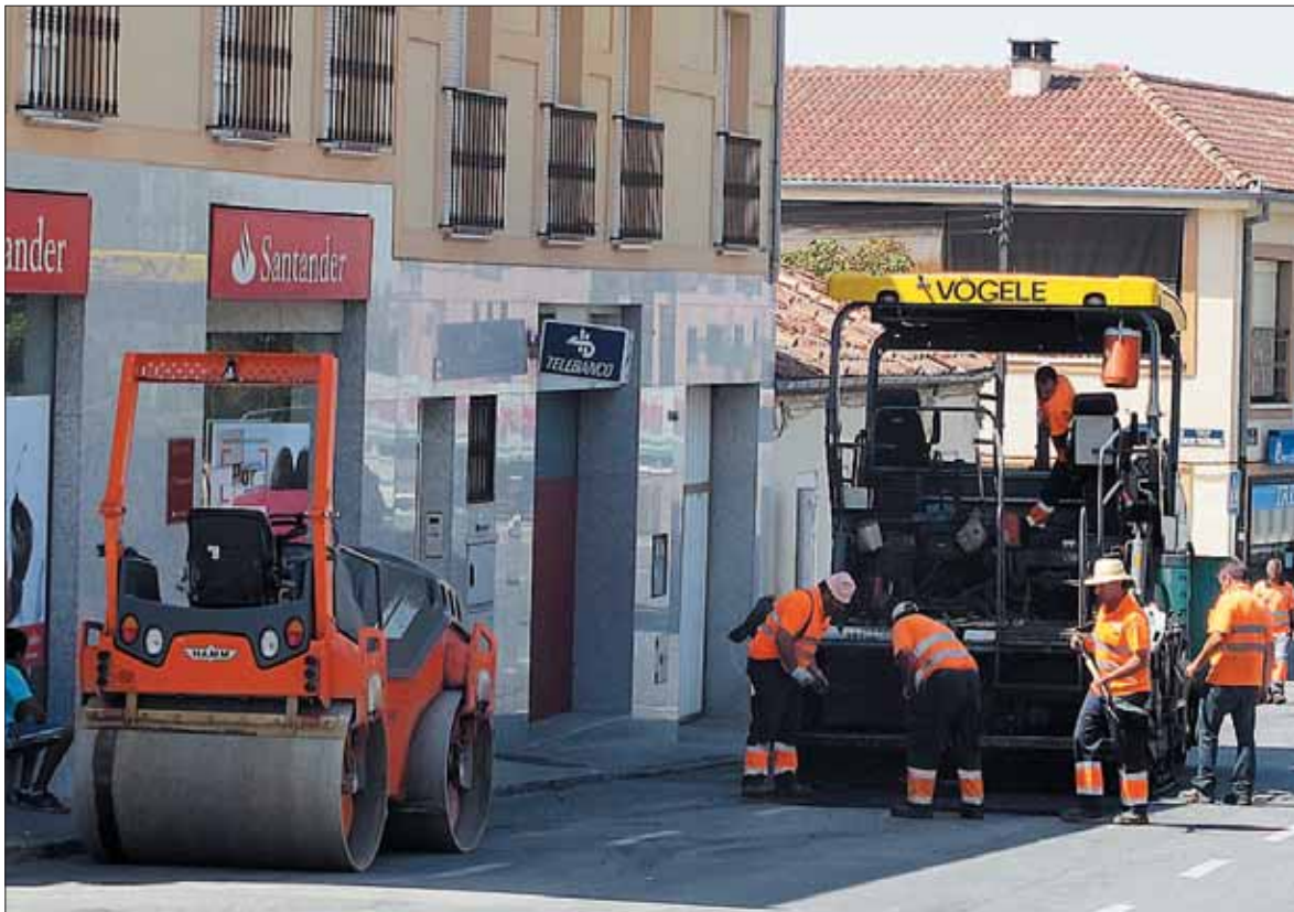
Los trabajos en el barrio de La Albuera finalizaron el pasado martes, reponiendo el firme en la calle Tejedores. / E. A.
