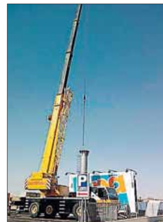
Una grúa retira la instalación. / E. A.
