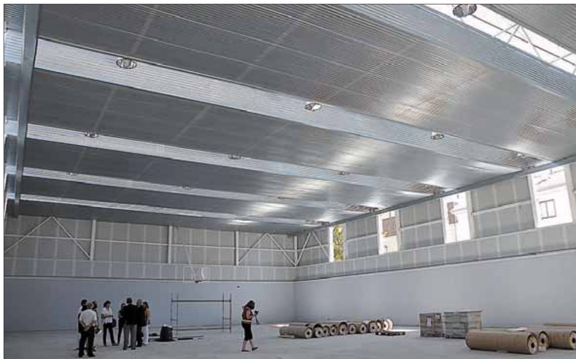
Interior del pabellón que se construye en el barrio de La Albuera, en terreno del centro público El Peñascal. / JUAN MARTIN
