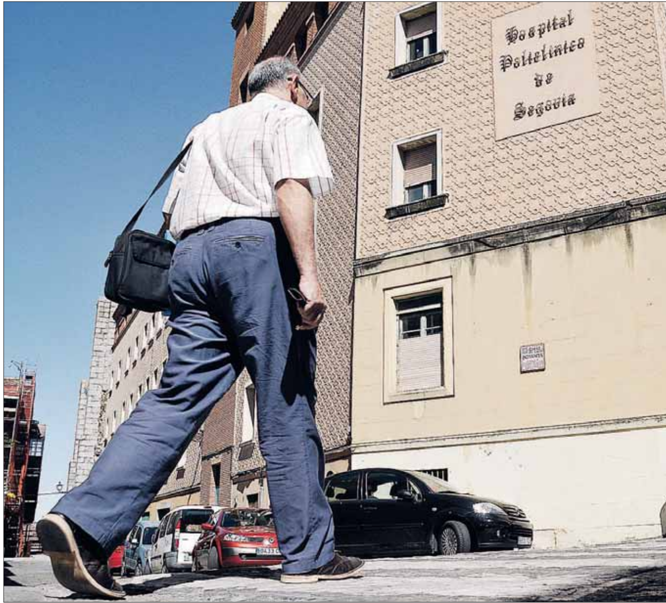
El inmueble construido entre 1942 y 1946 y conocido popularmente como el 'Dieciocho de julio' ha sufrido un proceso de deterioro y olvido,
