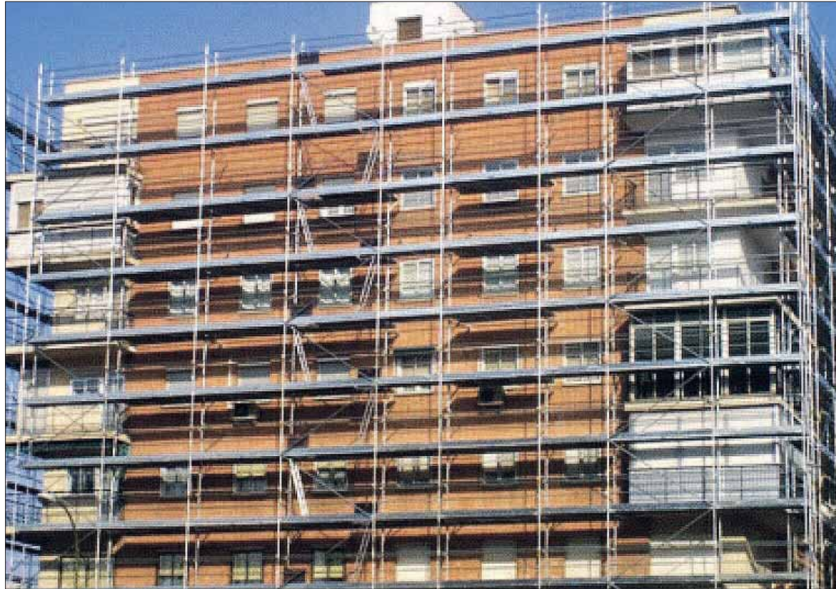
El andamiaje en la fachada de un edificio de viviendas evidencia que se va a someter a una rehabilitación. / AGENCIAS
