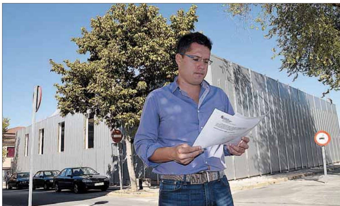
El concejal de Deportes, Javier Arranz, ante las obras inacabadas del pabellón deportivo del colegio El Peñascal. / JUAN MARTIN
