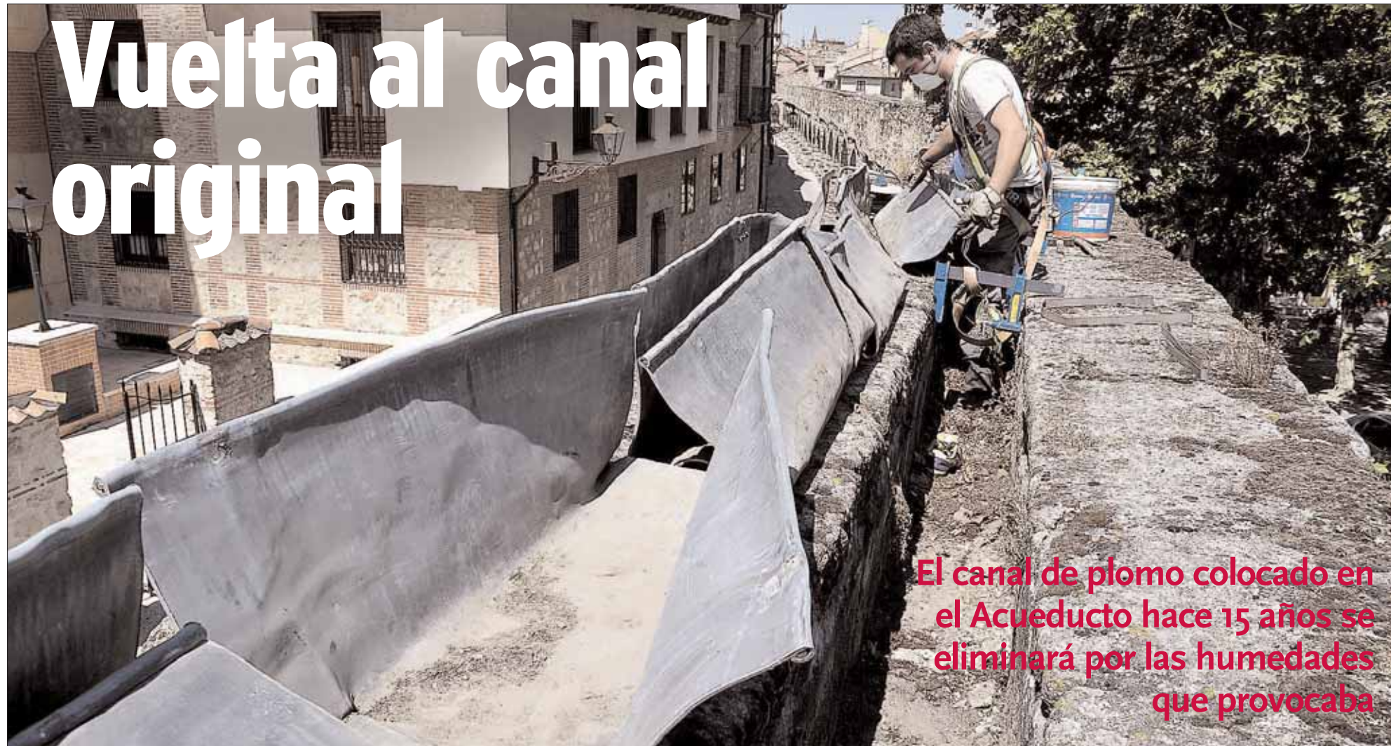
Un operario de la empresa adjudicataria de las obras, levantando el canal de plomo del Acueducto en las inmediaciones del desarenador de la calle San Gabriel, en la mañana de ayer. / JUAN MARTÍN
