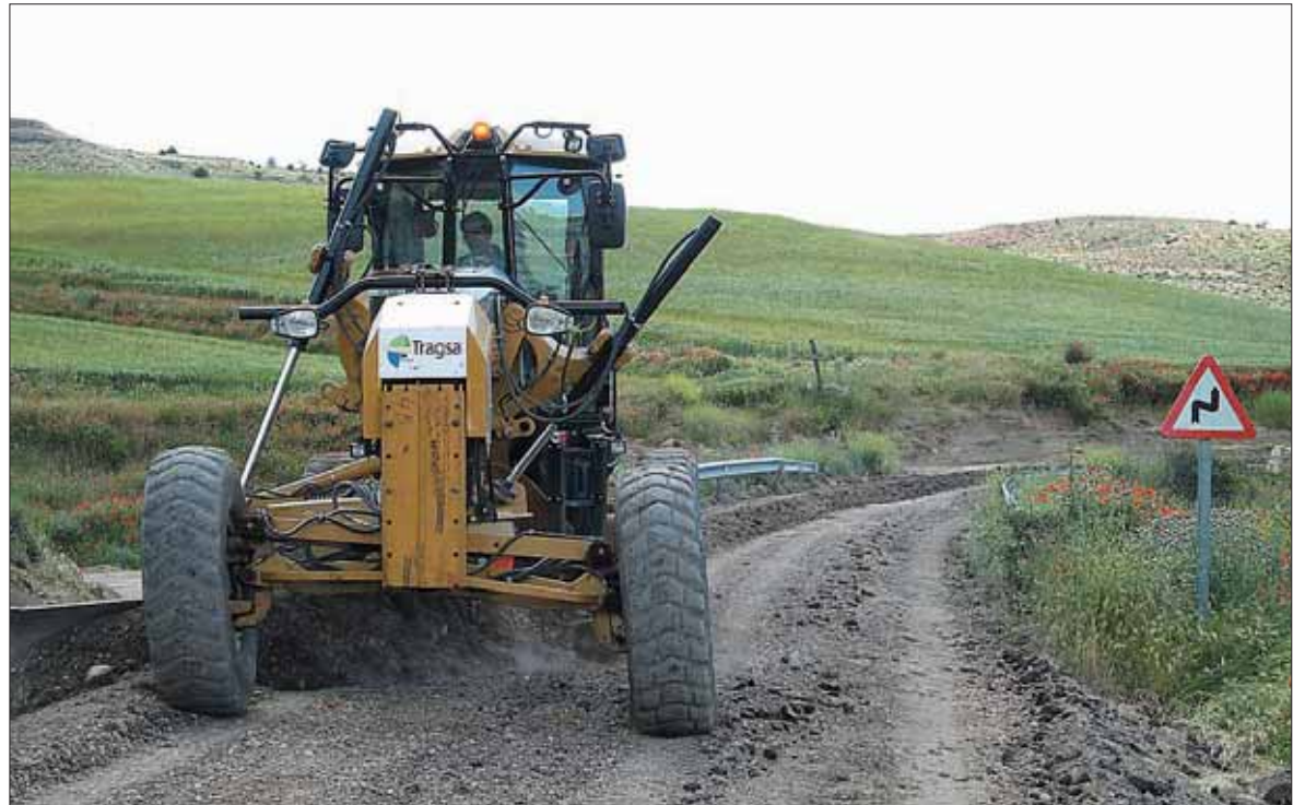
Imagen del camino de Mozoncillo durante su acondicionamiento. / EL ADELANTADO
