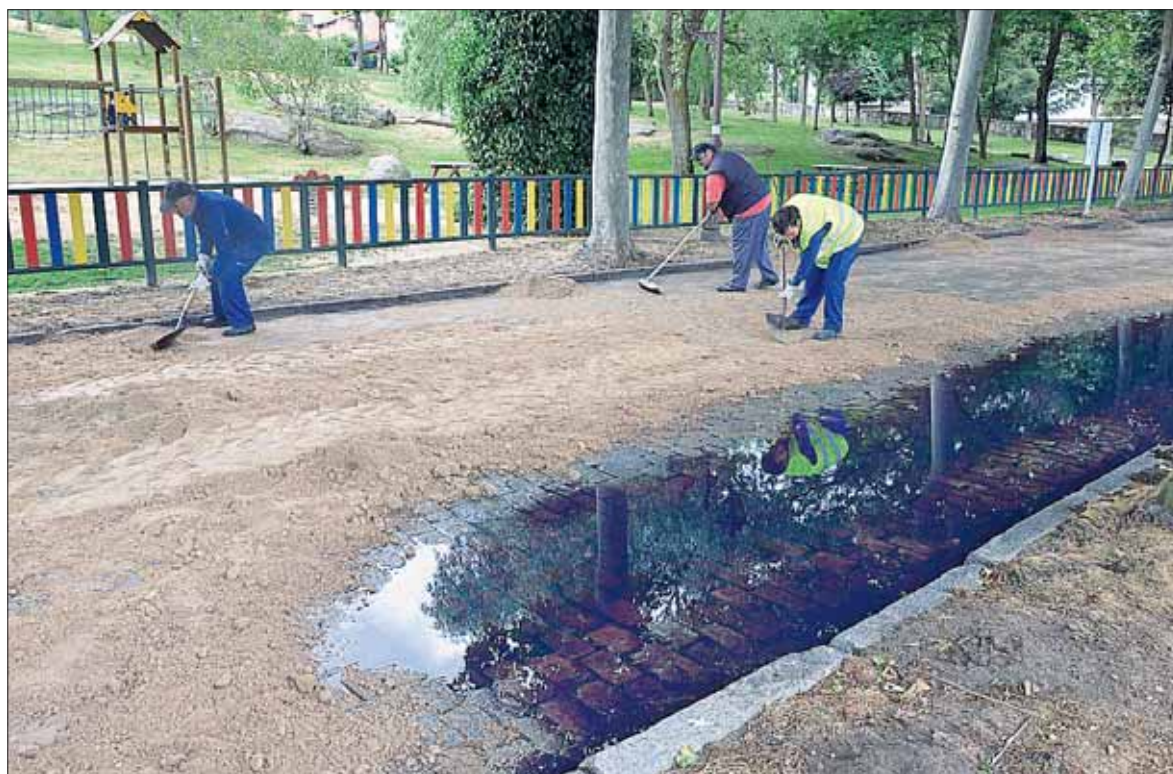
Operarios municipales limpiaron la vía después del accidente del camión, ocurrido el pasado día 2. / PEDRO L. MERINO
