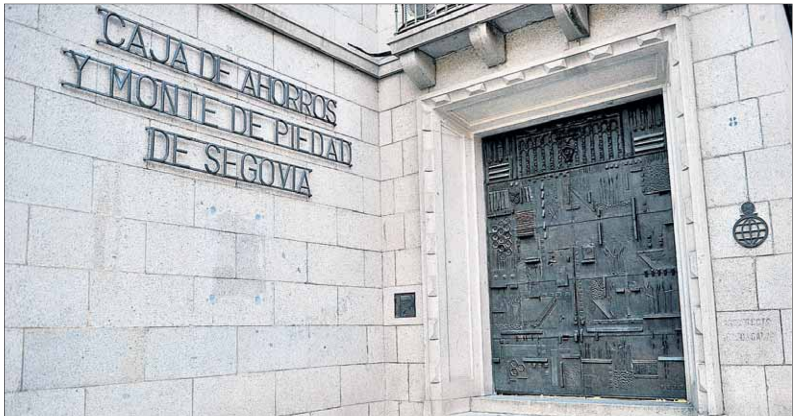
Fachada de lo que fue la oficina principal de Caja Segovia, en la Avenida Fernández Ladreda, cuya actividad financiera ha sido traspasada a Bankia. / KAMARERO
