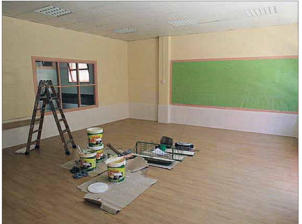
Realización de obras de pintura en un centro escolar de la Comunidad Autónoma. / AGENCIAS
