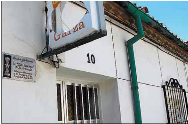
Pocas viviendas conservan el cartel del Instituto Nacional de la Vivienda de 1954.
