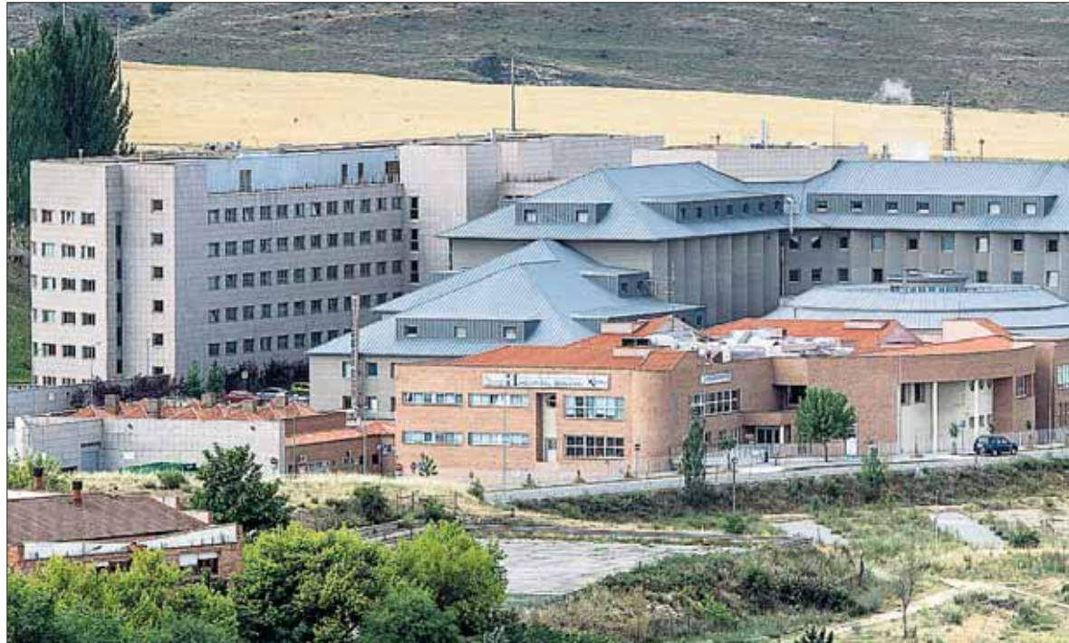
Exterior del Complejo Asistencial de Segovia, con diversos edificios dedicados a la Sanidad pública. / KAMARERO
