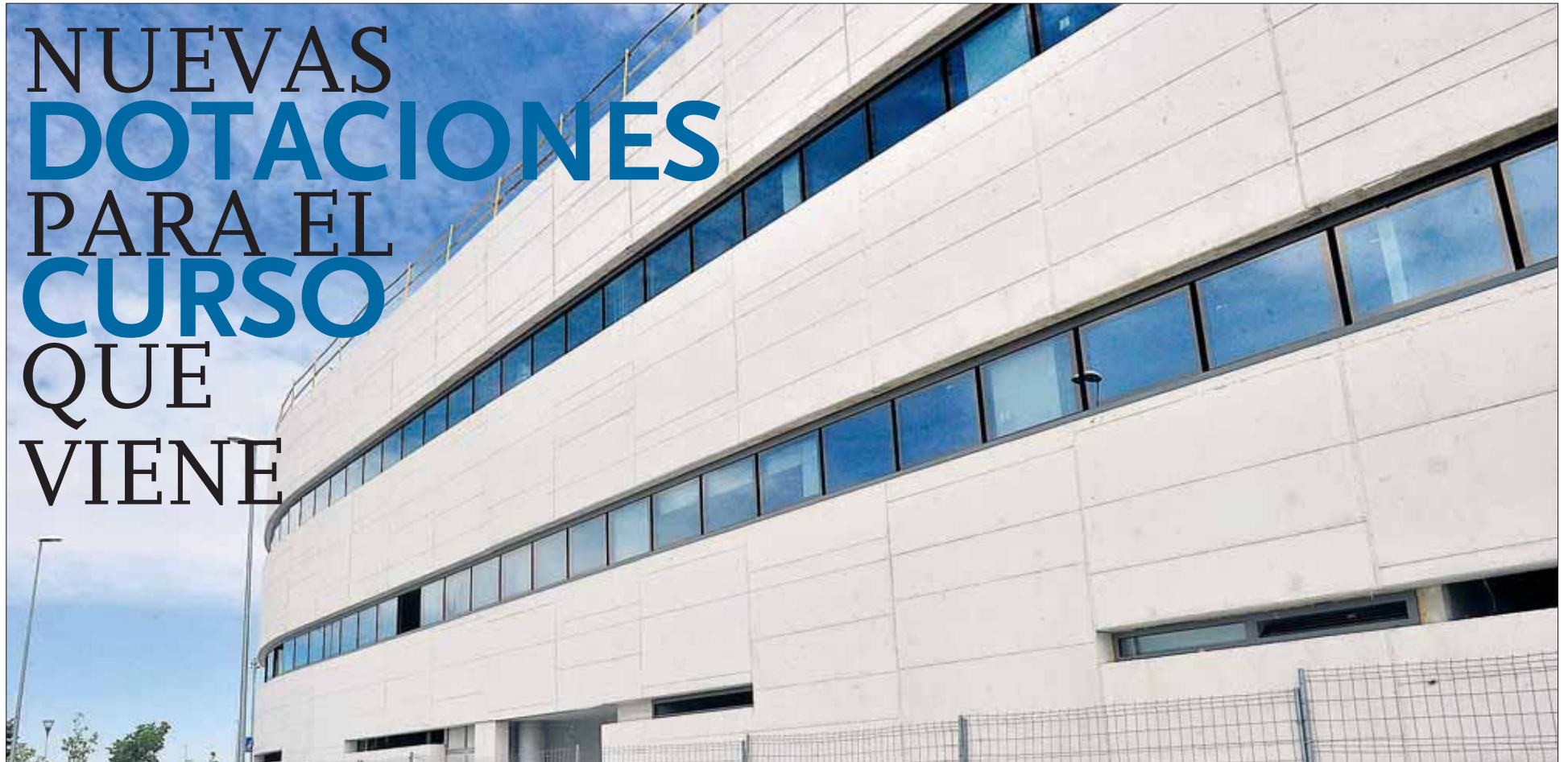
Las obras del imponente edificio de la Biblioteca Pública del Estado, en el barrio de Nueva Segovia, han llevado buen ritmo. Inicialmente estaba previsto que la ejecución finalizara el mes que viene. / KAMARERO
