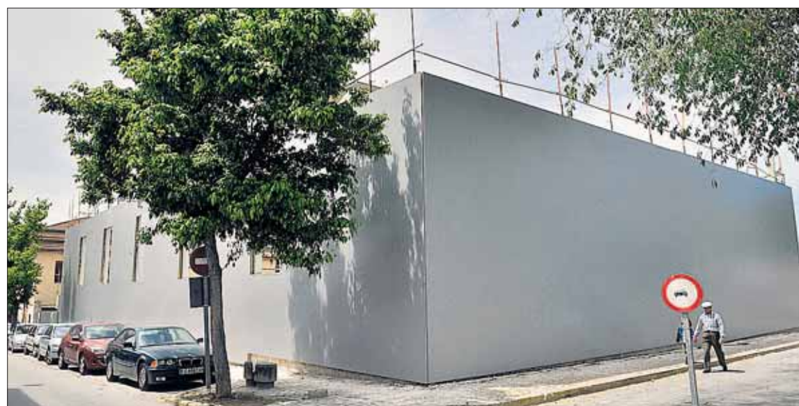
Los paneles ya se están colocando en los muros del pabellón, pero no son de hormigón armado. / KAMARERO
