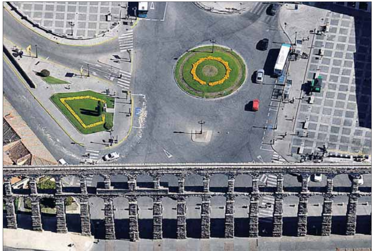
El estudio sobre el Acueducto cuenta ya con todos los pronunciamientos favorables. / KAMARERO
