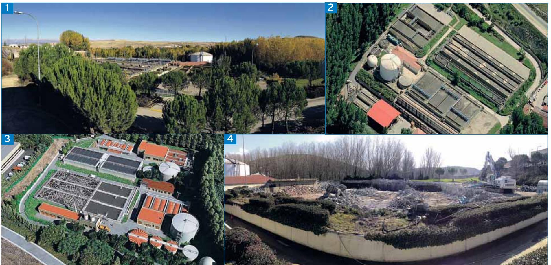
1. Fotografía de la situación actual del EDAR. 2. Vista EDAR actual. 3. Montaje de EDAR ampliada. 4. Demolición del decantador primario / EL ADELANTADO
