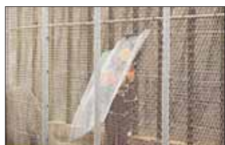
Un operario trabaja en la verja.
