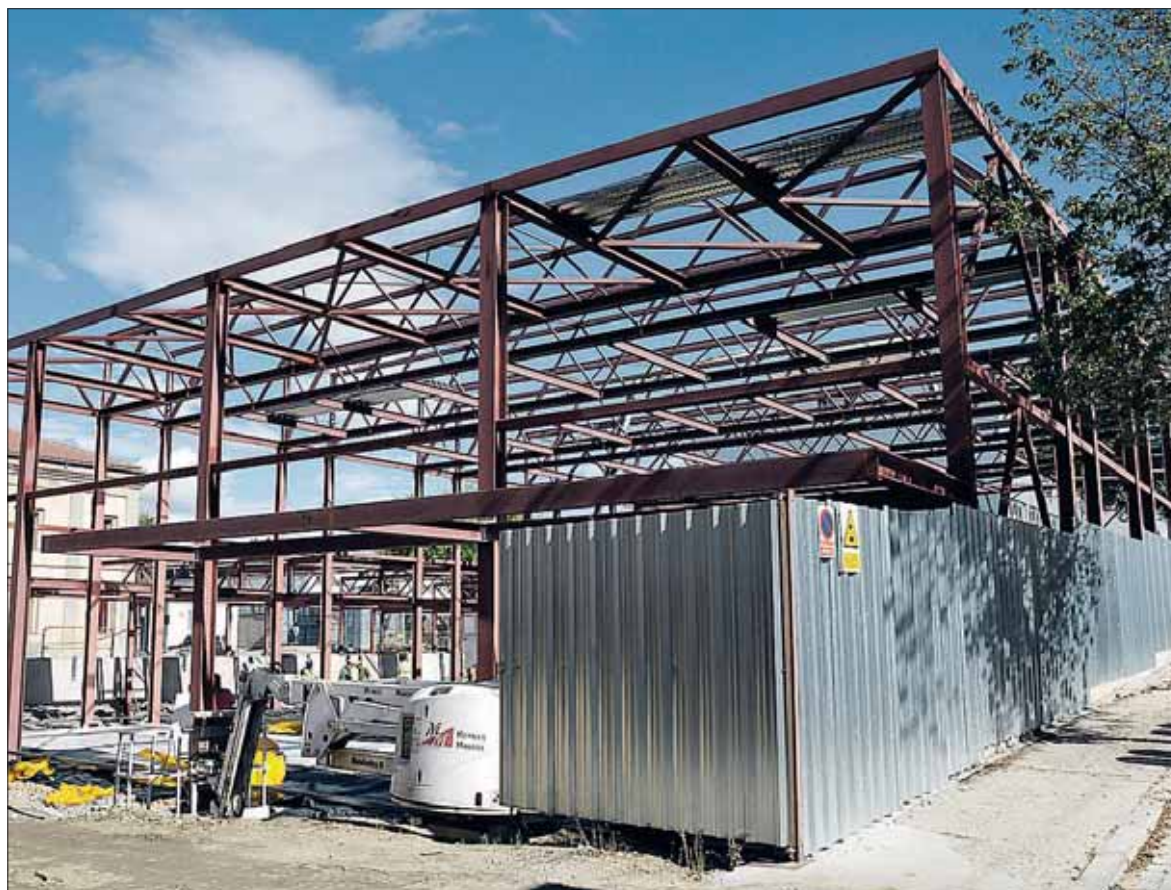
Las obras del pabellón del colegio se reanudaron el pasado mes de junio, después de estar dos años paralizadas. / JUAN MARTIN
