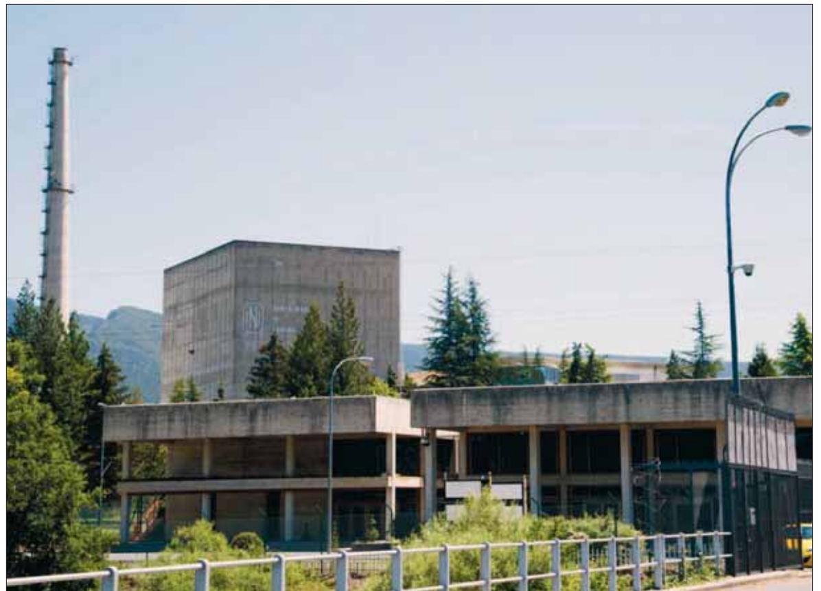
Imagen del exterior de la central nuclear de Santa María de Garoña, en Burgos. / RICARDO ORDÓÑEZ (ICAL)
