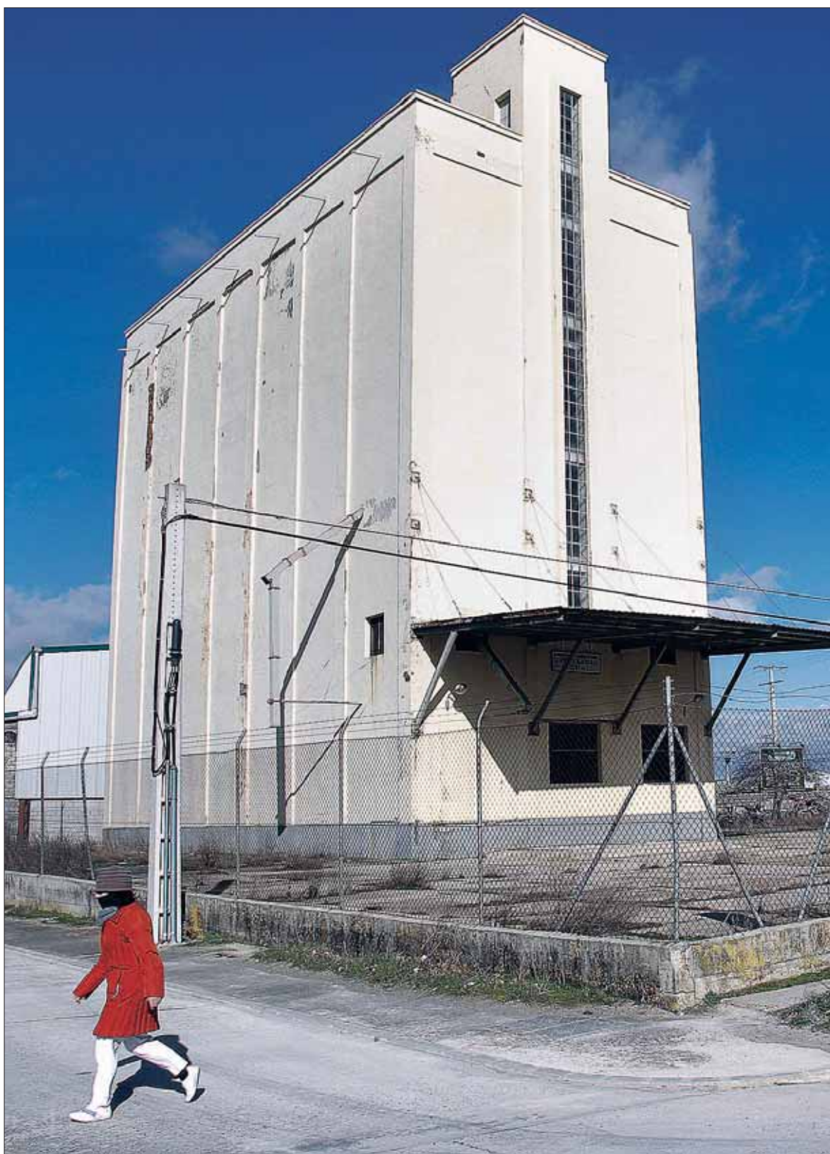
Silo ubicado en la localidad de Cuéllar, uno de los que forman la Red Básica del FEGA. / GABRIEL GÓMEZ GALICIA
