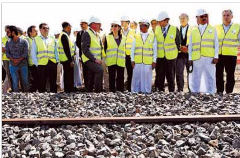
Pastor se desplazó hasta la localidad de Jeddah donde se ejecutan las obras. / EFE
