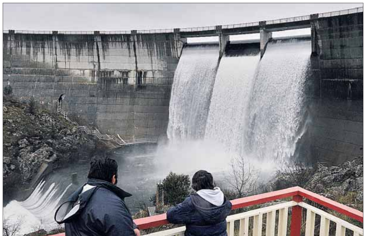
El embalse del Pontón Alto, en término de Palazuelos, vertía ayer agua por los aliviaderos de coronación. / KAMARERO
