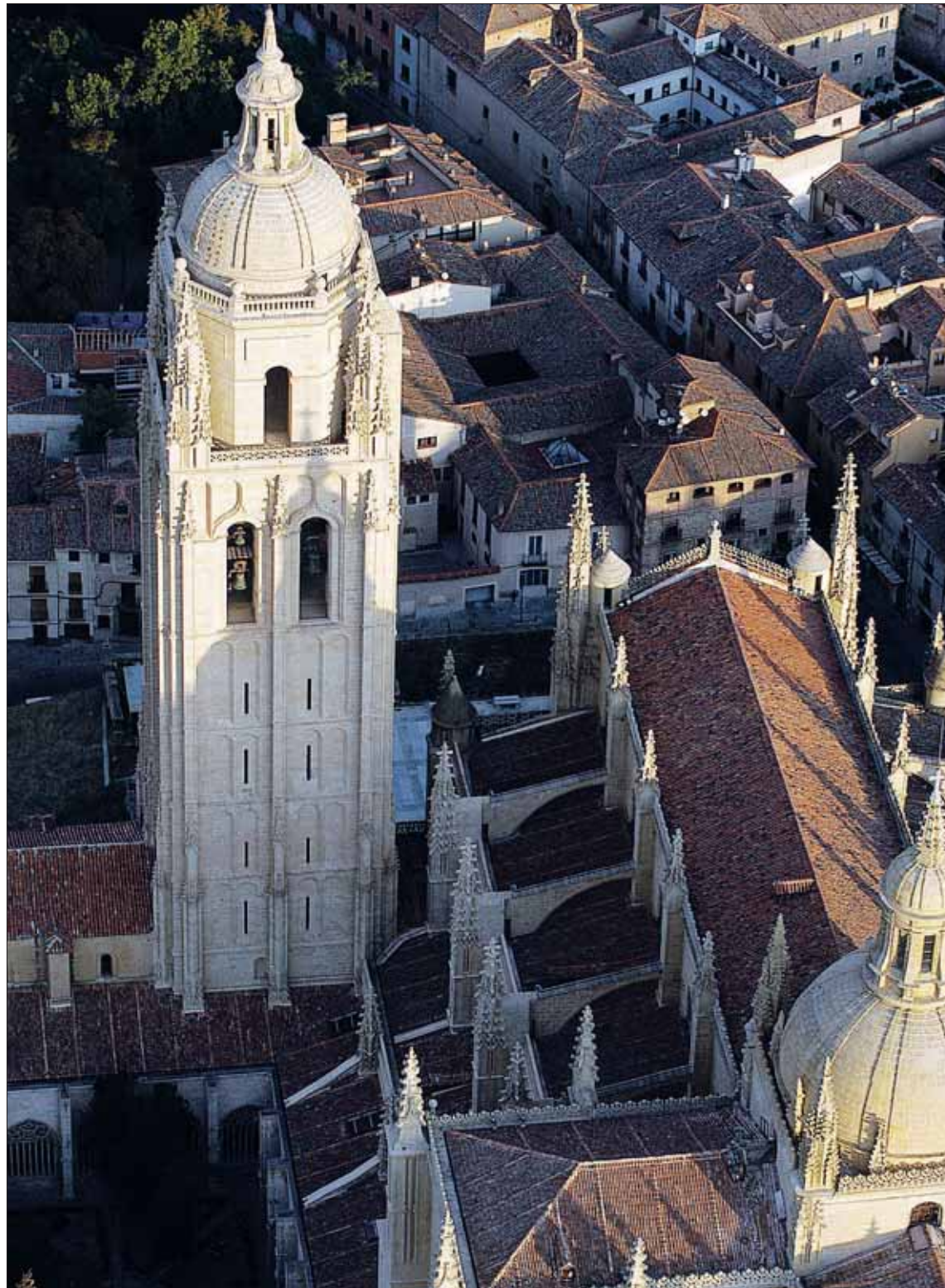
Vista aérea de la Catedral de Segovia, cuya cubierta será restaurada durante este año y 2015. / JUAN MARTÍN
