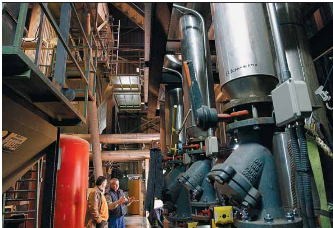
Interior de la Planta de Biomasa de la villa tras el inicio de las obras de mejora. / GABRIEL GÓMEZ
