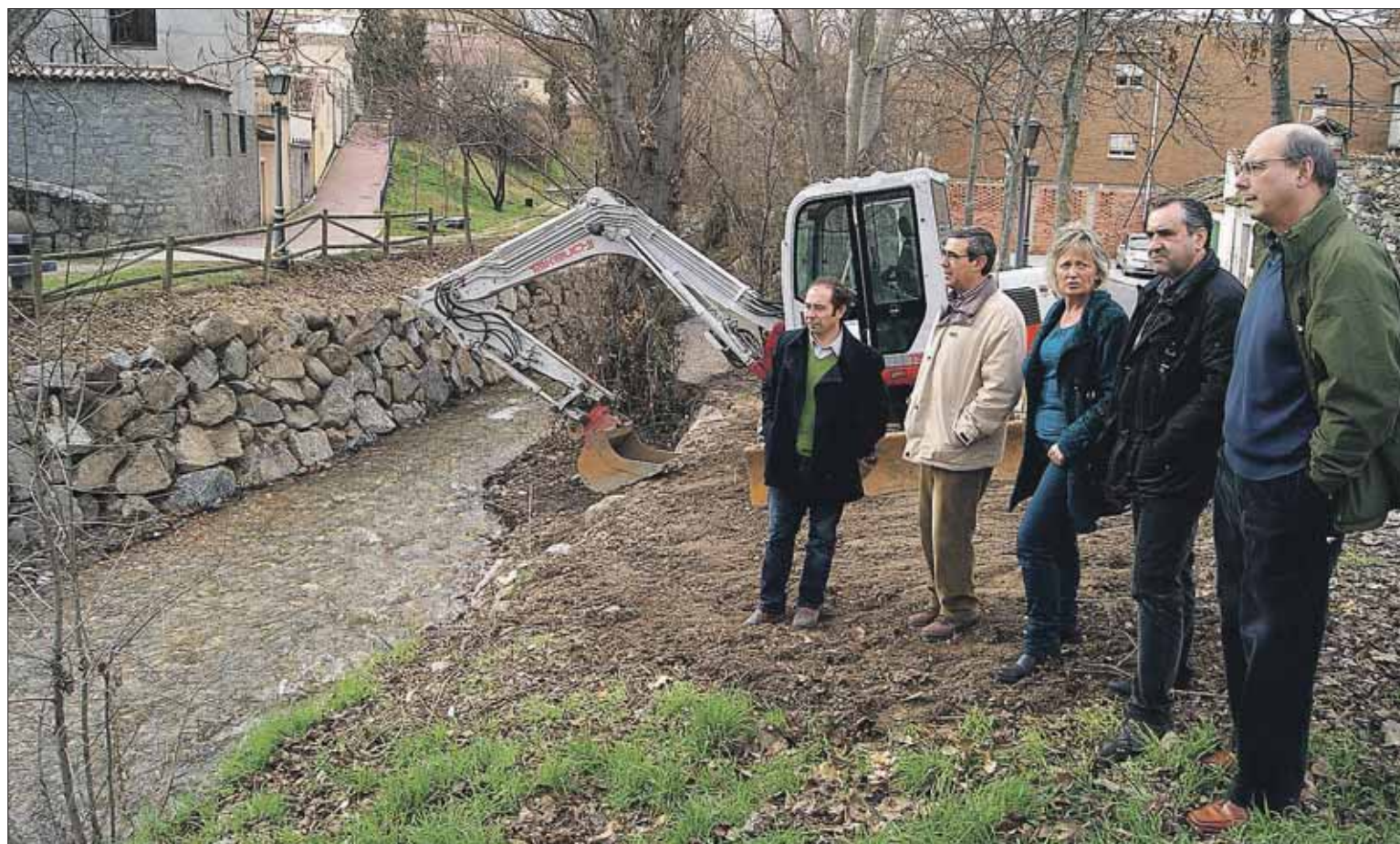
La concejala de Medio Ambiente, Paloma Maroto, visita las obras de recuperación de la ribera del río Ciguñuela acompañada de los técnicos de la CHD. / EL ADELANTADO
