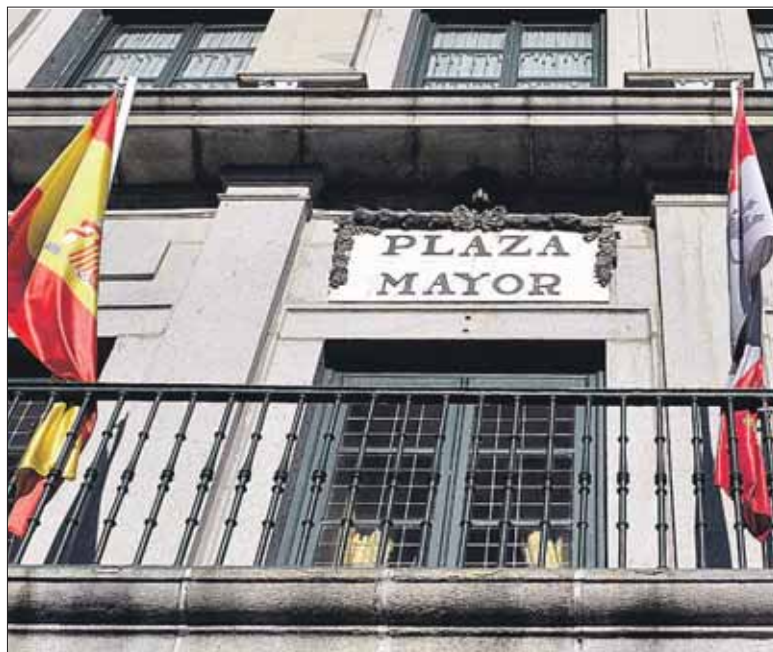
Balconada del edificio principal del Ayuntamiento, en la Plaza Mayor. / KAMARERO
