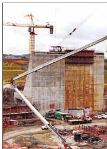
Trabajos de ampliación del canal.
