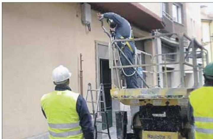
Foto facilitada por un vecino donde los operarios reparan la acometida dañada.
